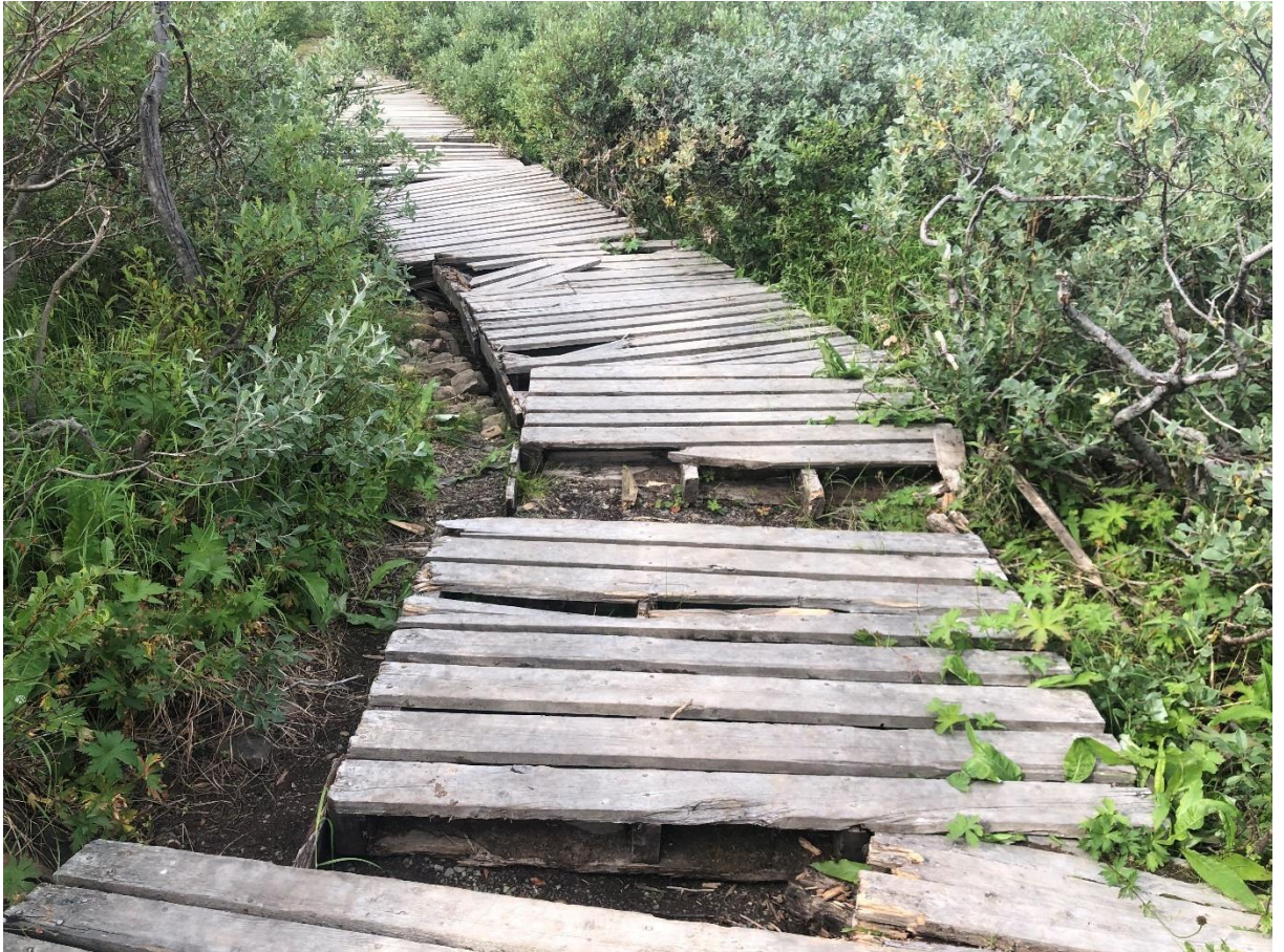
Klopp ved brua over Storelva som man må krysse på vei opp til Nattfjelldalen – skiftes ut.
