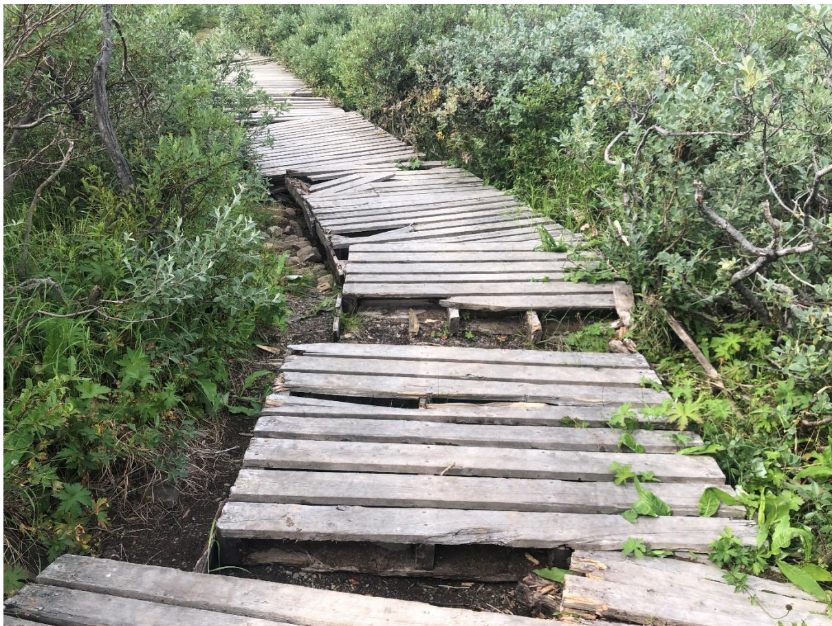
Klopp ved brua over Storelva – Nattfjelldalen – skiftes ut
