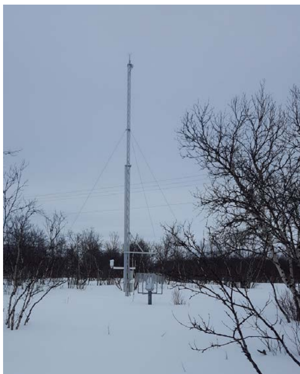
Figur 3.8.4. Ny infrastruktur (base og referansestasjoner) i COATs klimaobservasjonssystem . A) Automatisk værstasjon med gittermast. B) Automatisk værstasjon med gittermast og Geonor nedbørmåler
