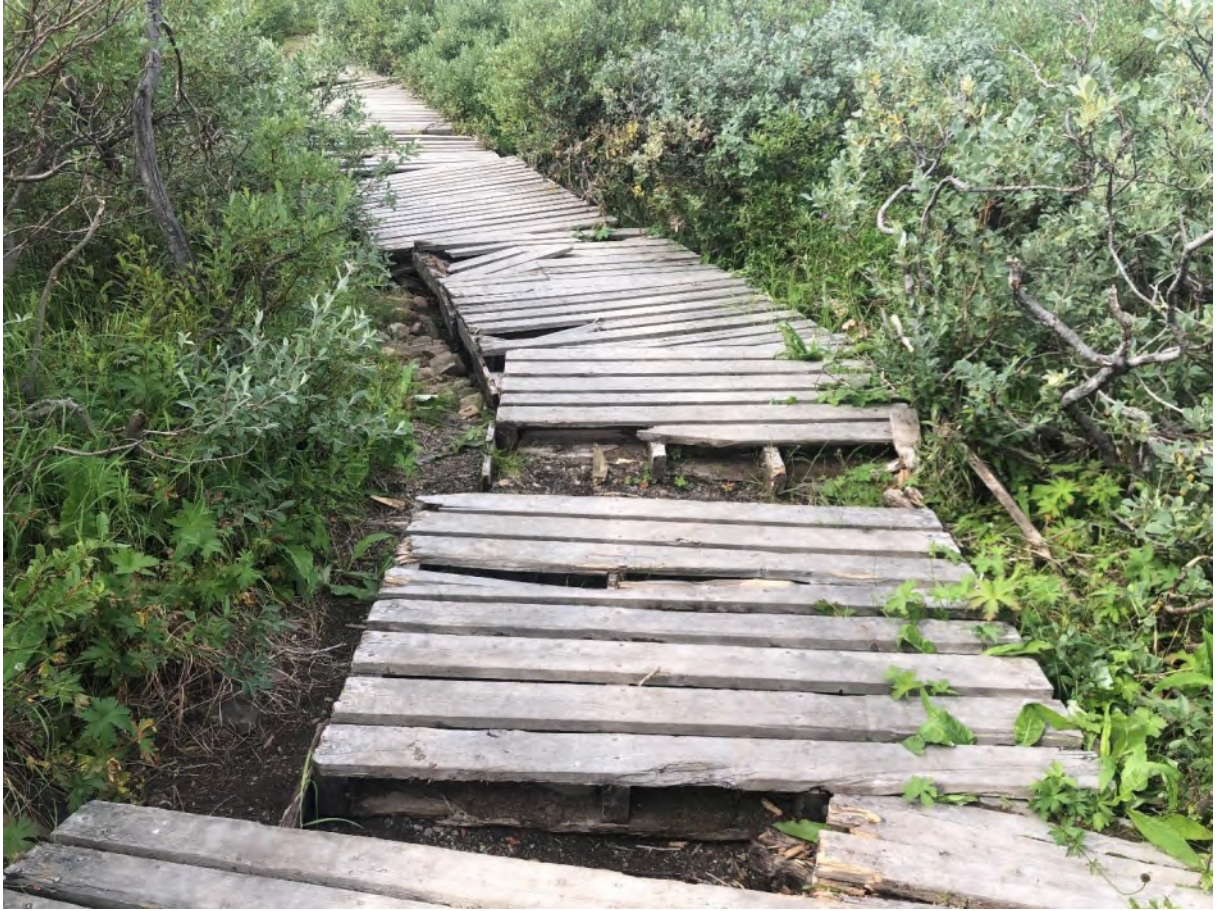
Klopp ved brua over Storelva som man må krysse på vei opp til Nattfjelldalen – bør skiftes ut.
