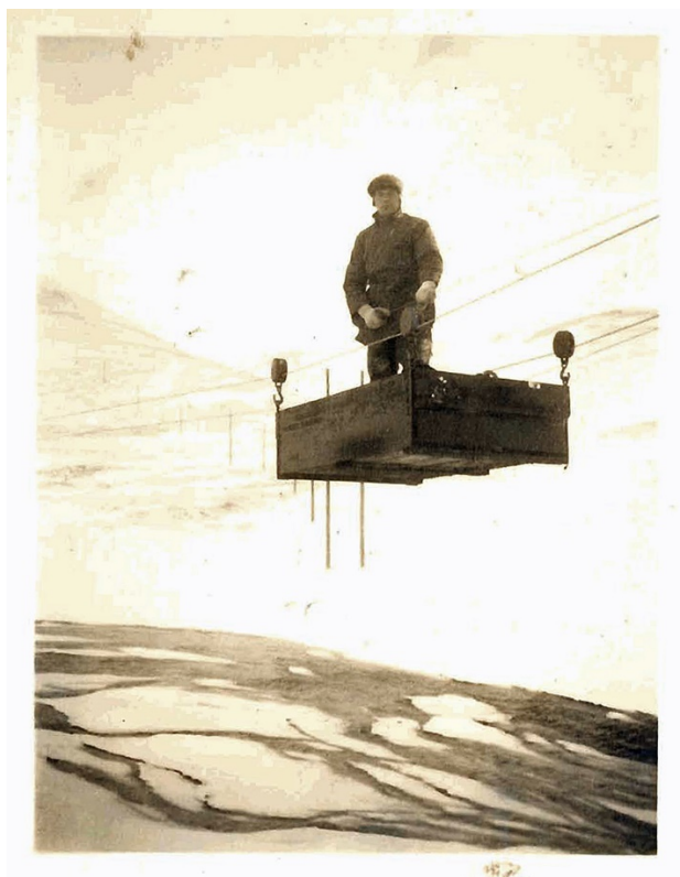
Telegrafhytta. Taubane over Sandfjordelva. 20 m over elva? Erling Nilssen. Stolperrekka oppover Raet ferdig montert.
