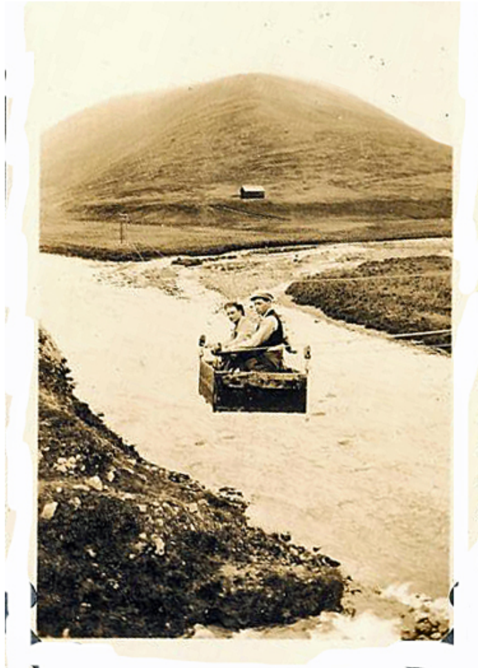
Telegrafhytta 1926. Taubane over Sandfjordelva. Stolperække opp Raet er ikke montert. Leif Boer Møller Hamborg + Ukjent.
