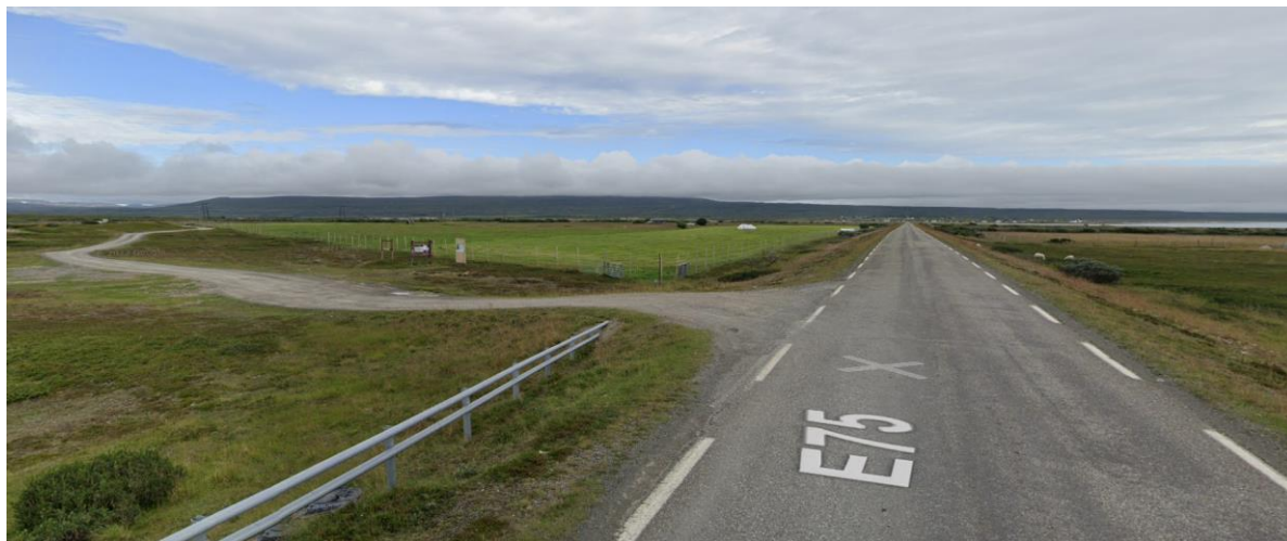
Figur 12 Adkomst til planområdet skjer fra E75. Tiltak som følge av planforslaget er utbedring av krysset.
