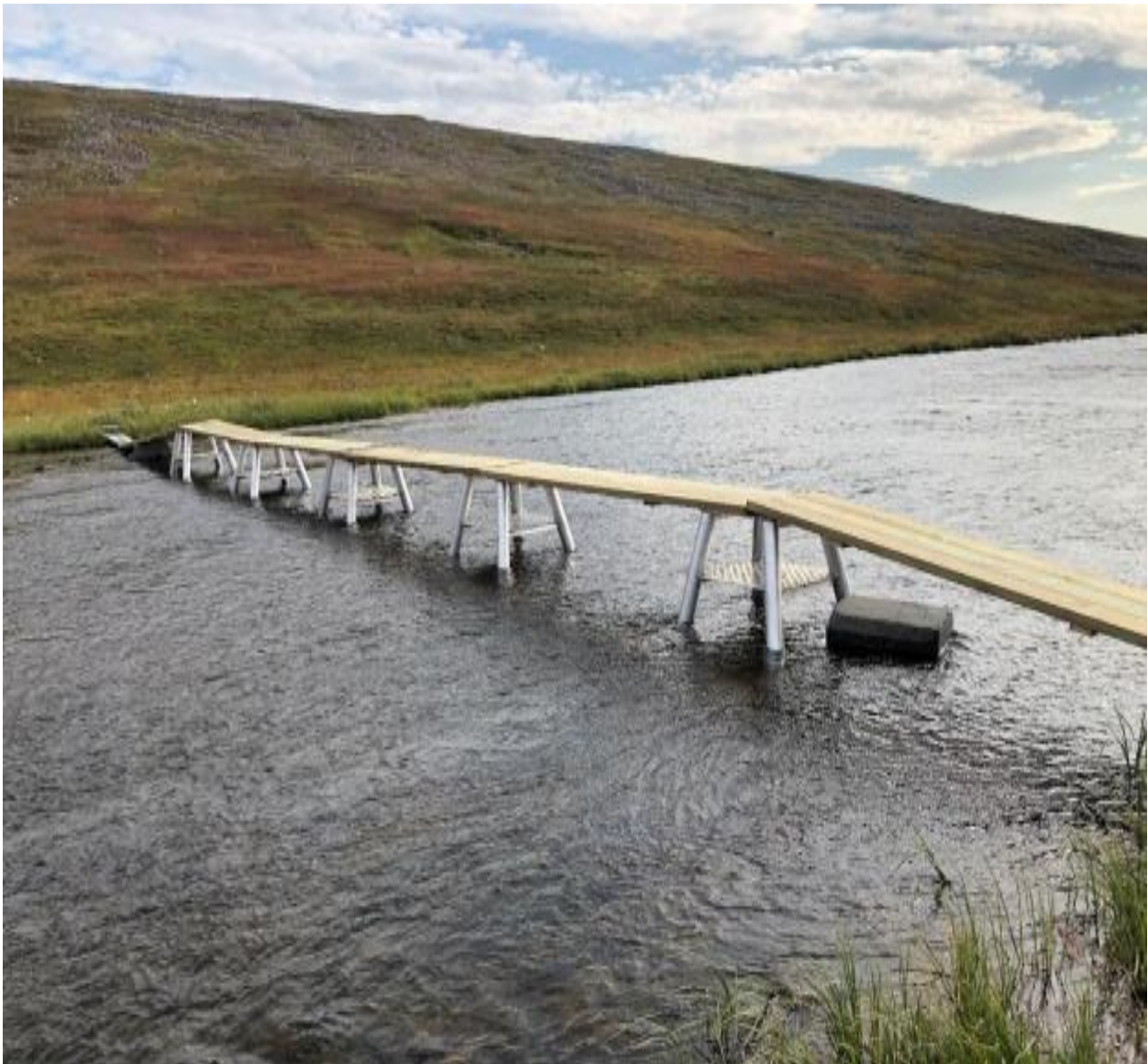
Løsning for bru ved utløp av Oarddojávri, Kloppbru, 2021.
