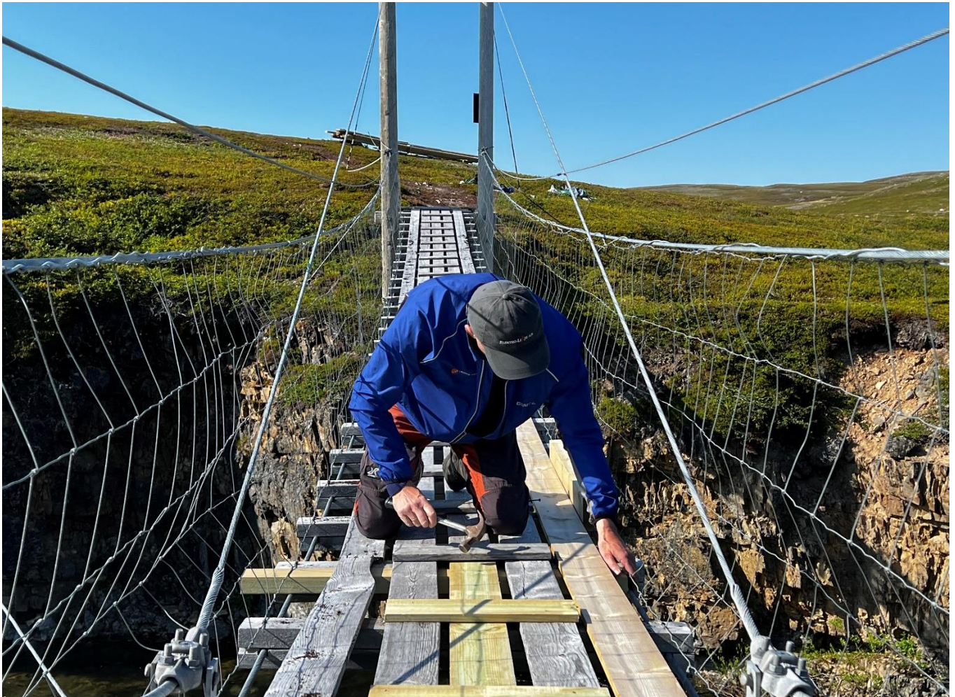
Tilsyn og reparasjon av hengebru i Komagdalen
