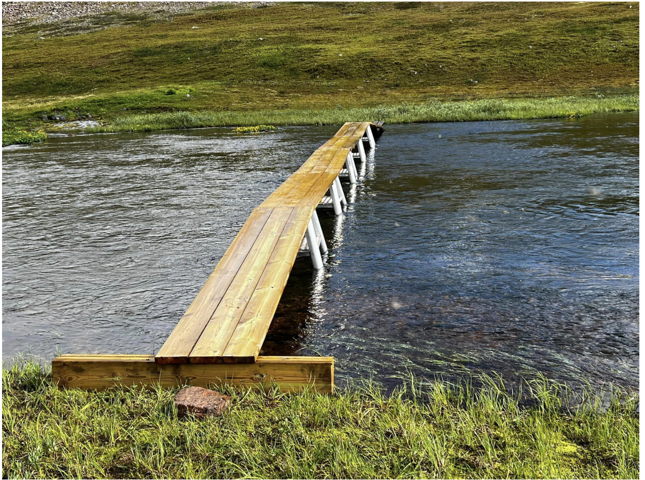
Bru utplassert sett fra nordvestsida
