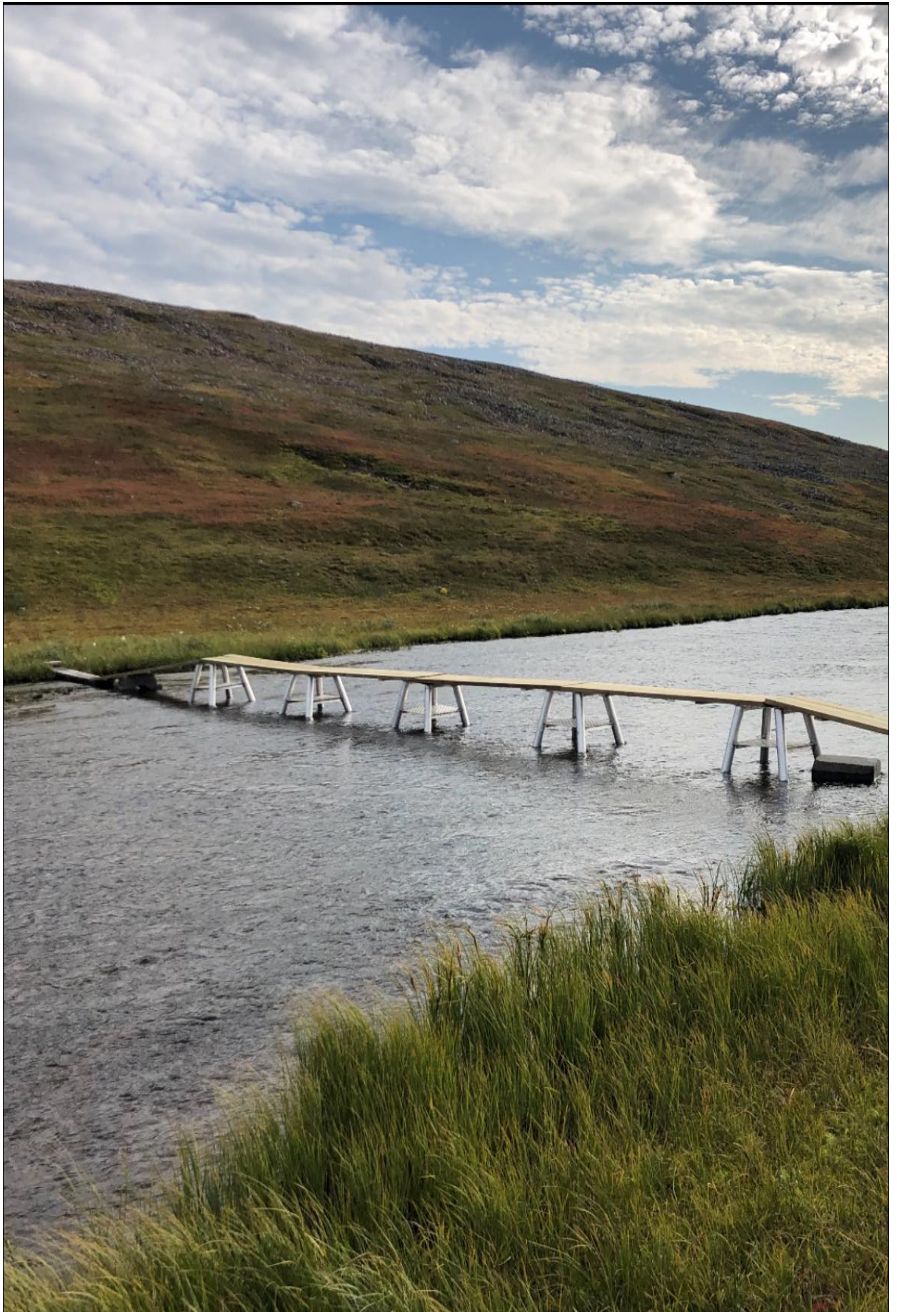
Bru sett fra nordsida (steinene i elva hører ikke til brua)
