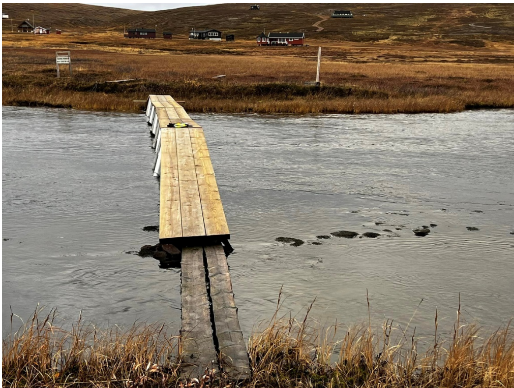
Bru ferdig utplassert fra sydøstsida
