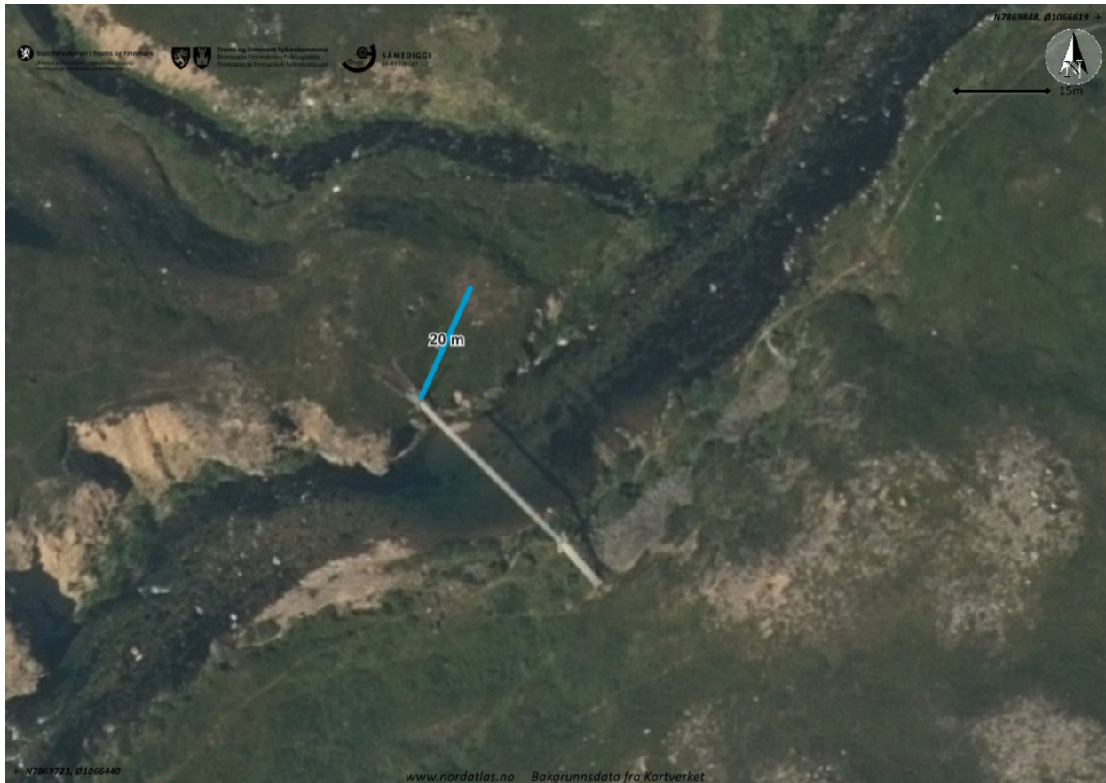
Hengebrua – 20 m illustrert på nordsiden av elva.
