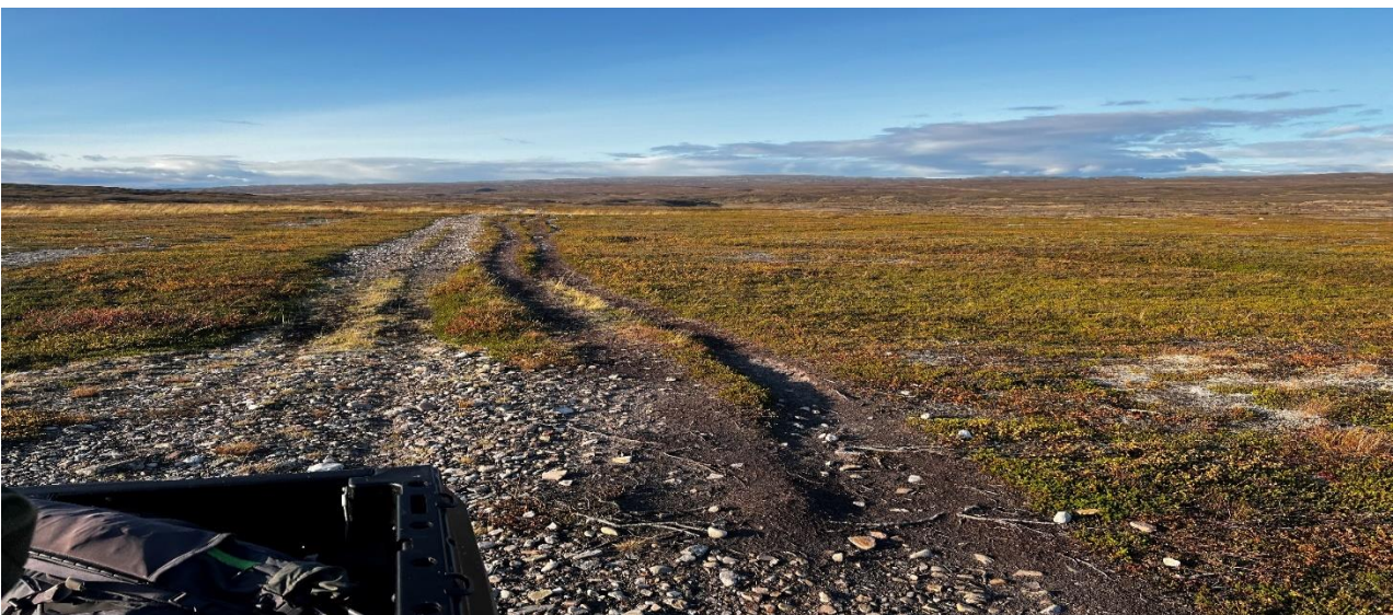
Uheldig utvikling av parallelle spor langs kjøresporet inn til Veisendehytta i Komagdalen vil vi forsøke å forhindre i 2024 ved å gruse midtpartiet av kjøresporet slik at det blir bedre å gå i selve kjøresporet, fremfor gåing parallellt på lyngrabbene.
