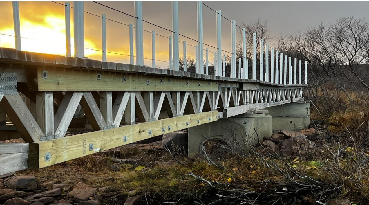
Brua over Sjøbuselva langs sti til Nattfjelldalen ble forsterket senhøsten 2022.
