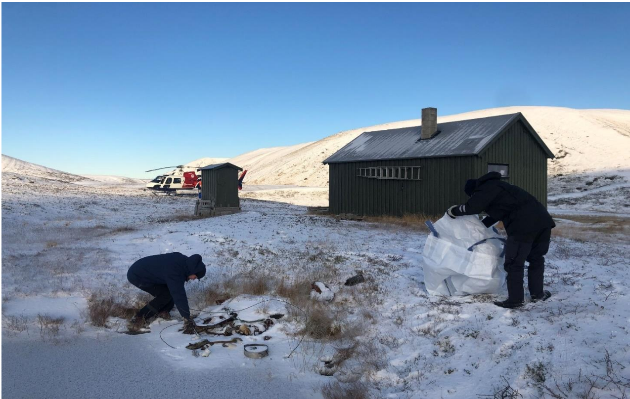
Metallskrap fra en dam ved Telegrafhytta i Sandfjorddalen ble fjernet. Hele 2 m 3 ! .
