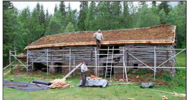
Reparasjon av låvetak ved Granneset. Foto: Kristian Sivertsen
