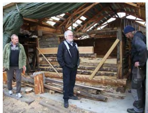
Restaurering av Fjellrosen. Foto: Ole Petter Rundhaug
