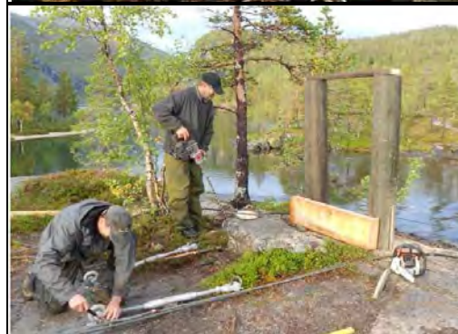
Oppsetting av ny hengebru over utløpet av Storskogvatnet. Foto: Stein Ove Johannessen og Tore Veisetaune.
