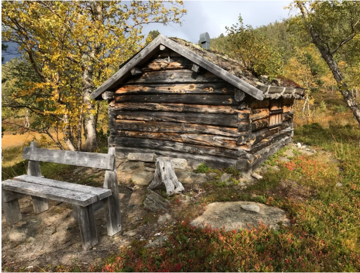
Bilde 2 Visuelt er det ei veldig flott tømmerkoie, men skinnen kan bedra. Tømringa er nærmest hul inni på grunn av råte.
