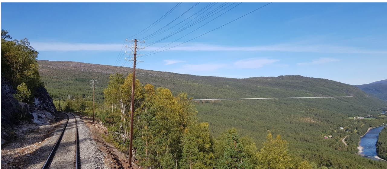
Figur 21 Foto i retning nordover. Russånes skimtes lengst nord til høyre. Jernbanesporet er markert med grå linje (Foto: Magne Haukås)
