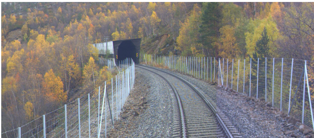
Figur 2 Bilde av eksisterende viltgjerde fra Lønsdal til Kjemåga (Foto: Bane NOR)
