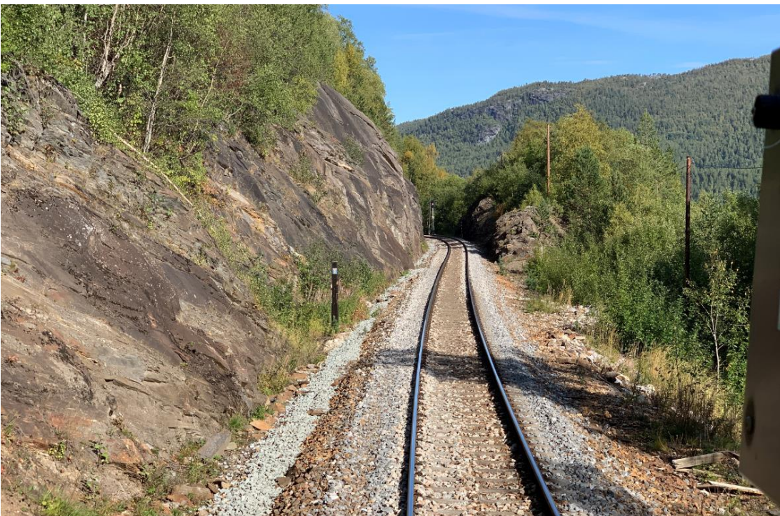
Figur 17. Mot Russånes tunnel ved Bleiknes. Gjerdet vil bli avsluttet ved tunnelåpningen i bakgrunnen. Foto 09.09.19 M Selnes
