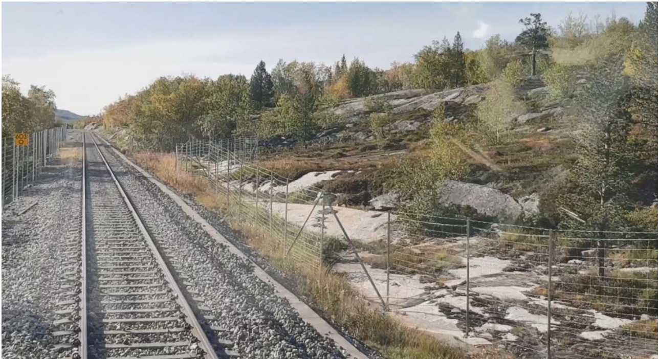
Figur 11 Bildet viser del av rein- og viltgjerde hvor gjerdet er oppført i et terreng der det legger seg mye snø om vinteren. Snø og skavler gjør at rein kan komme seg over gjerdet. (Foto: Magne Haukås)
