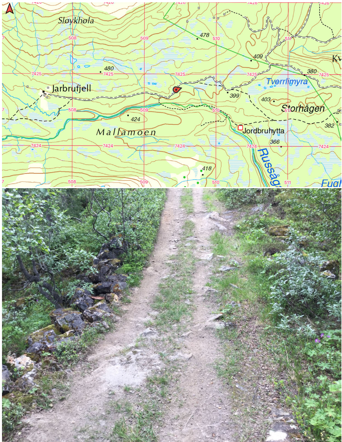
Figur 13. Punkt 9. Eksempel på gammel oppfylling/forstøtning av kjøresporet med stedeagne masser som glir godt inn i terrenget uten noen negativ påvirkning på naturverdier. Steinen er brutt ut fra berget i øvre billedkant (til høyre). UTM 33W 509444 7424782 Link til punktet i Norgeskart.
