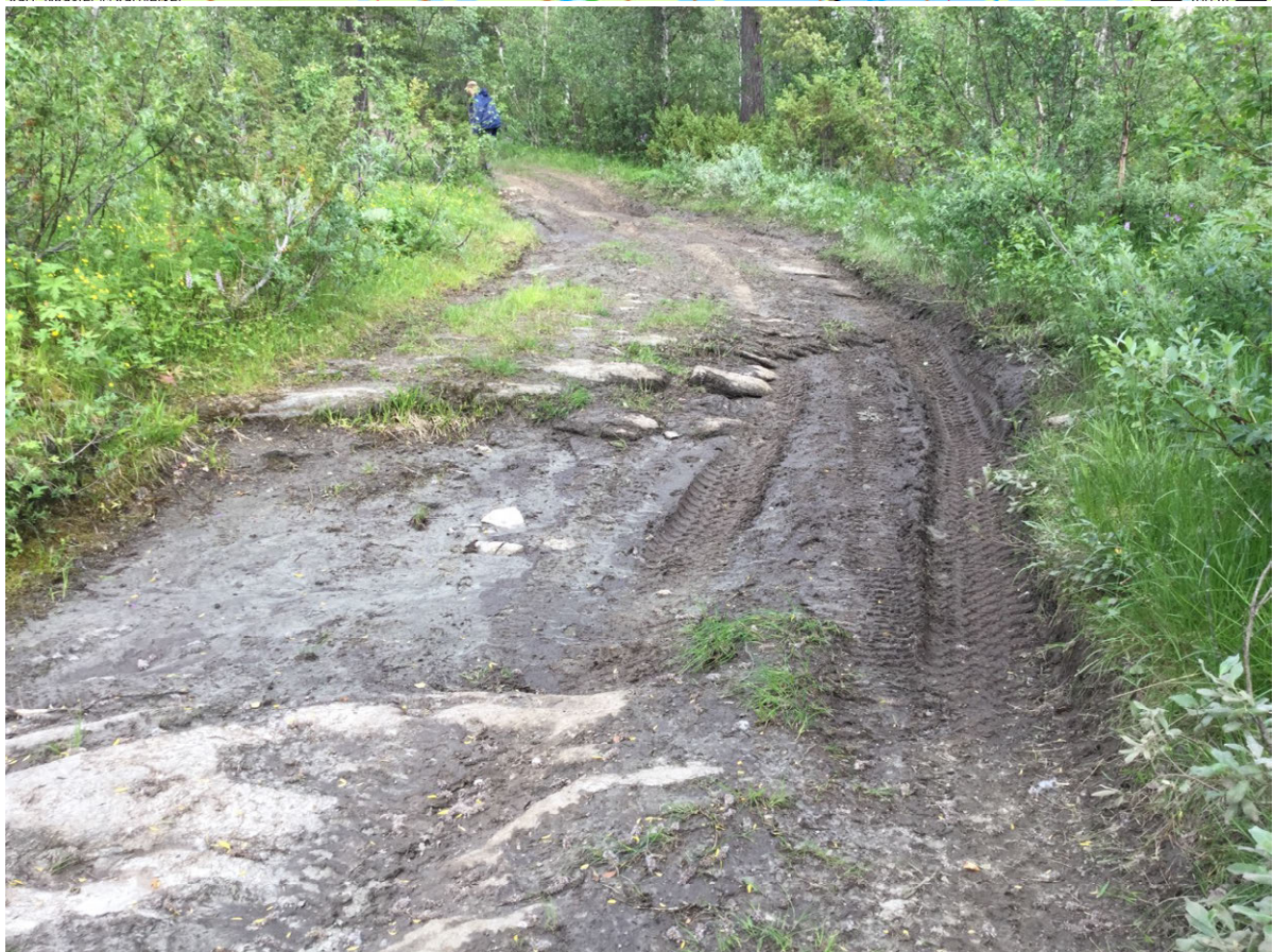
Figur 17. Punkt 13. Punkt der kjøresporet har blitt bredere enn nødvendig fordi man har prøvd å unnvike et gjørmehull. Her kan det fylles med stedegen kuppelstein/pukk for å reetablere kjørespore i kun én kjørebane. Det er ingen nevneverdige naturverdier her. UTM 33W 510487 7424900 Link til punktet i Norgeskart.
