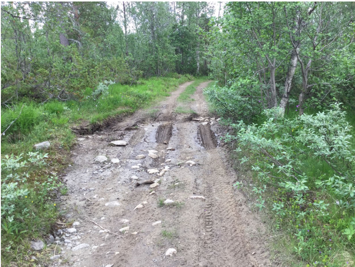
Figur 10. Punkt 6. Gjørmete parti gjennom svakt kalkrik myrkanntmark. Her er det laget en enkelt dreneringsløsning fra før. Det er mulig å forbedre også denne for å unngå at kjøringen eroderer enda mer ned i lømassene. UTM 33W 509663 7424883 Link til punktet i Norgeskart.
