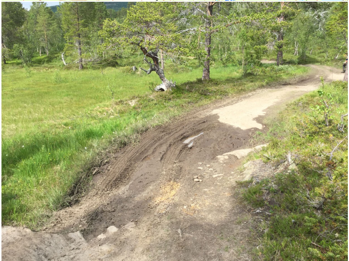
Figur 8. Punkt 4. Gjørmete parti gjennom myr med intermediær karakter. Myra er ikke så rik som i punkt 1, men det kan med fordel også her gjennomføres drenering i kjøresporet og påfyll av grove masser (eventuelt kun det siste), slik at man unngår en utvidelse av trasébredden og at opprotet mineralmateriale og humus fra kjøresporet skylles ut på myra i regnværperioder. UTM 33W 509970 7424931 Link til punktet i Norgeskart.
