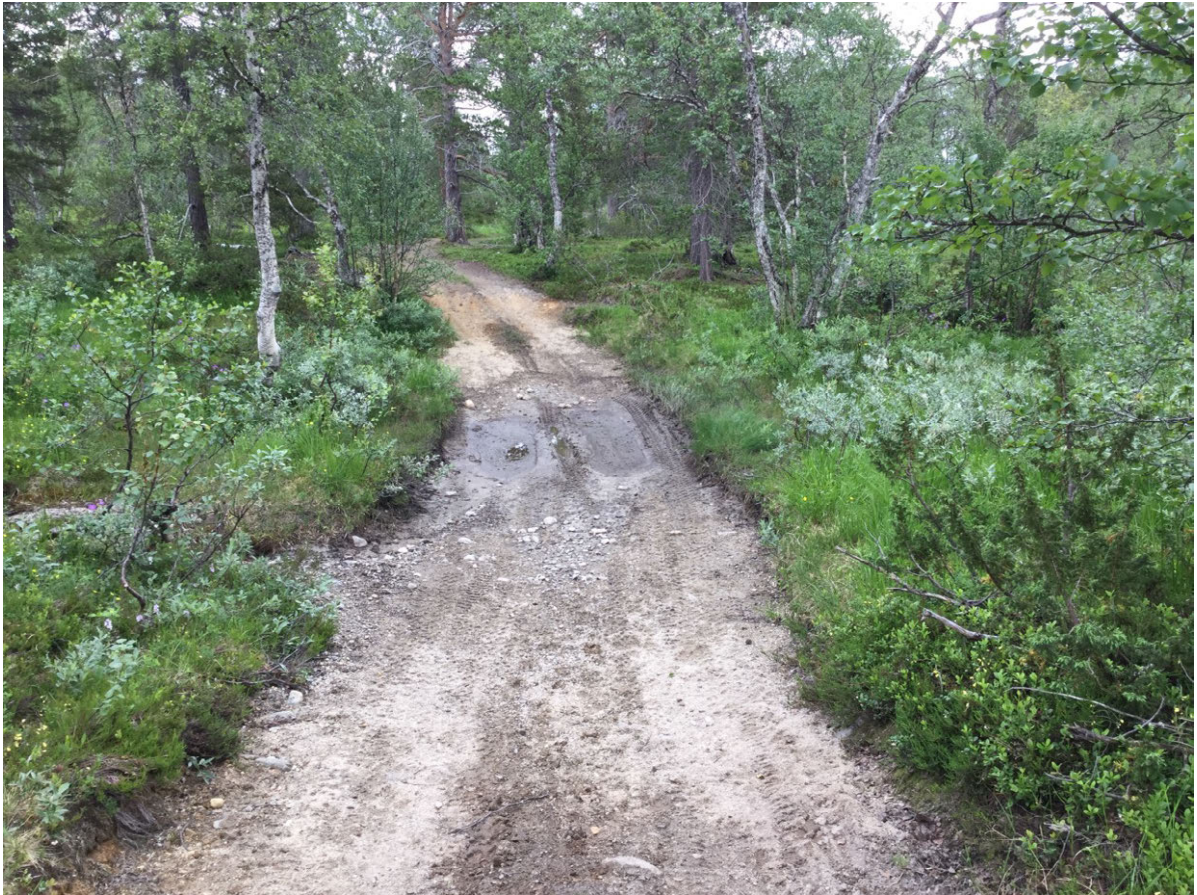
Figur 9. Punkt 5. Gjørmete parti gjennom svakt kalkrik myrkantmark. Har liten innvirkning på viktige naturverdier, men drenering og/eller noe drenerende masser på det laveste partiet vil likevel være en fordel. UTM 33W 509750 7424903 Link til punktet i Norgeskart.
