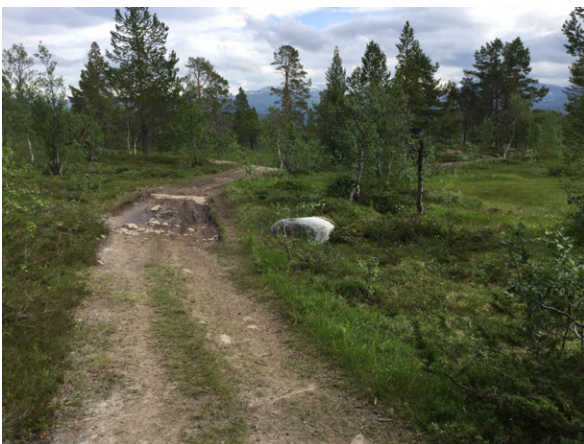
Figur 6. Punkt 2. Kjøresporet splitter to myrarealer som opprinnelig har en sammenheng i et søkk der den øvre myra (sørsiden av vegen) drenerer ut i den nedre myra. Den nedre myra er ei rikmyr. Den øvre er intermedieær. Kjøresporet endrer på den naturlige dreneringen, noe som er uheldig. Dette kan rettes opp ved å legge drenerør på det laveste punktet på kjøresporet og grove drenerende (stedegne) masser oppå der. Ei grøft i den nedre myra (nordsiden av vegen) bør fylles mest mulig igjen, men uten bruk av anleggsmaskin i myra, slik at man unngår uttørring. Koordinater: UTM 33W 510048 7424901 Link til punktet i Norgeskart.
