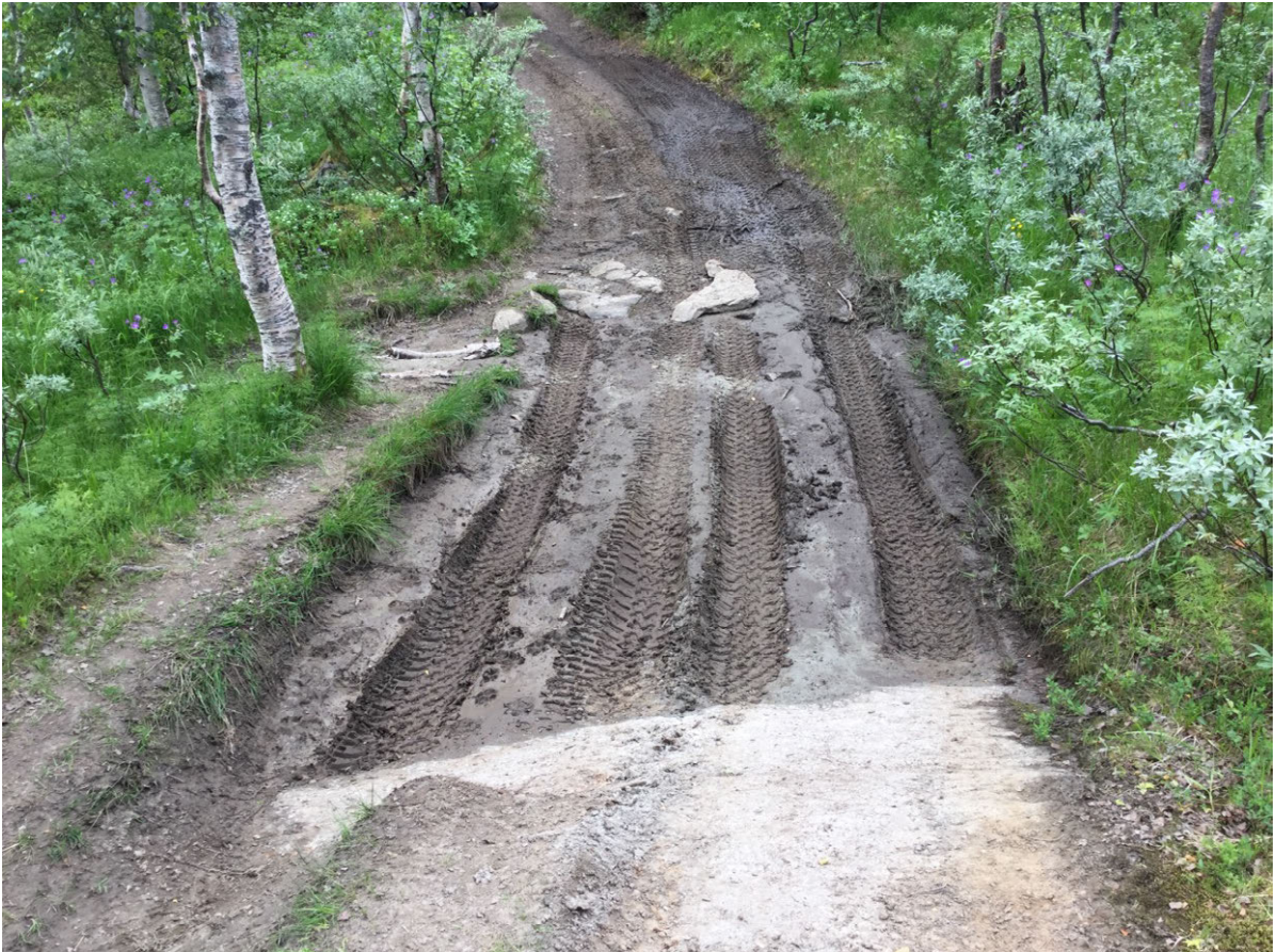
Figur 12. Punkt 8. Gjørmete parti gjennom litt kalkrik myrkanntmark. Her stopper ikke kjøresporet naturlig drenering, og noe negativ virkning er ikke mulig å se fra om lag en meter ut til siden. Drenering og/eller noe grove drenerende masser (stedegen pukkestein eller lignende) vil likevel være en fordel for å unngå ytterligere utvasking. UTM 33W 509466 7424821 Link til punktet i Norgeskart.
