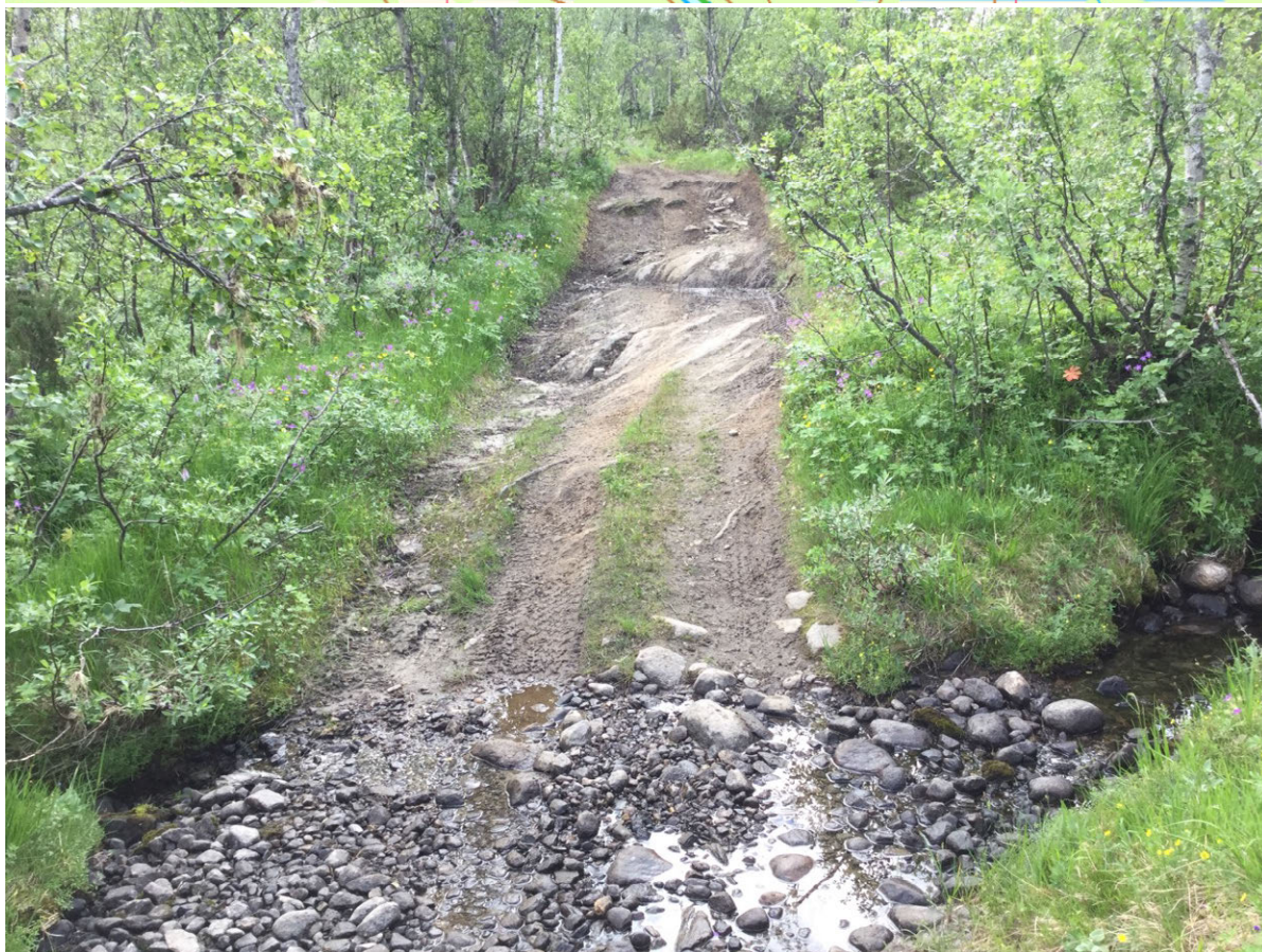
Figur 16. Punkt 12. Punkt vest for Tverrlimyra der det ikke er nevneverdige naturverdier, men der vegen med fordel kan planeres noe med grove, stedeagne masser, eventuelt at det legges plank eller lignende i hjulsporene, for at den skal framstå bedre i landskapet. Over bekken bør det eventuelt legges drenering og/eller grove drenerende steinmasser. UTM 33W 510335 7424839 Link til punktet i Norgeskart.
