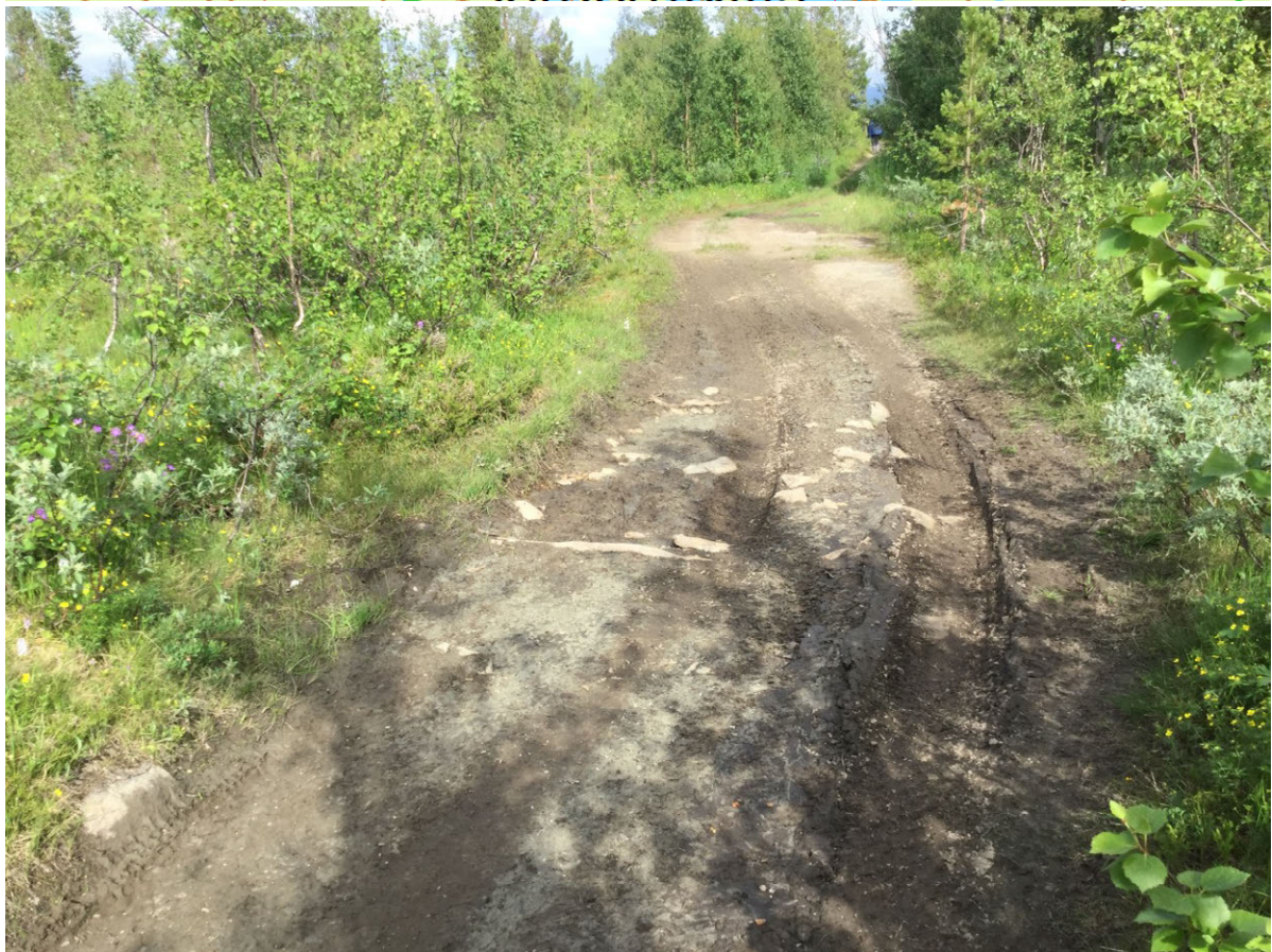
Figur 18. Punkt 14. Også dette er et punkt der kjøresporet har blitt bredere enn nødvendig fordi man har prøvd å unngå et gjørmehull. Her kan det fylles med stedefgen kuppelstein/pukk for å reetablere kjøresporet i kun én kjørebane. Her er ingen nevneverdige naturverdier. Herfra og utenfor verneområdegrensa er kjøresporet mer forseggjort. UTM 33W 510620 7425019 Link til punktet i Norgeskart.
