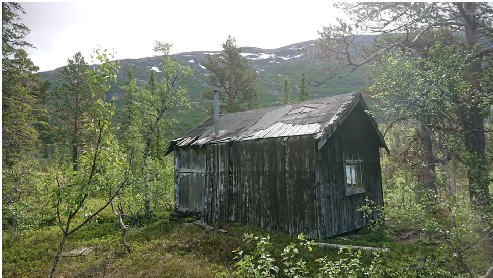
Bilde 4 Hytta sett fra nord. Bakveggen er i ferd med å gli inn i hytta, stor åpning i veggen og takpapp spredt i terrenget.
