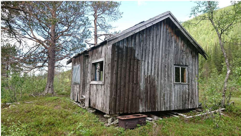
Bilde 5 Hytta sett fra øst. Vinduene mangler glass og det er brukt plast for å "bøte" på skadene.
