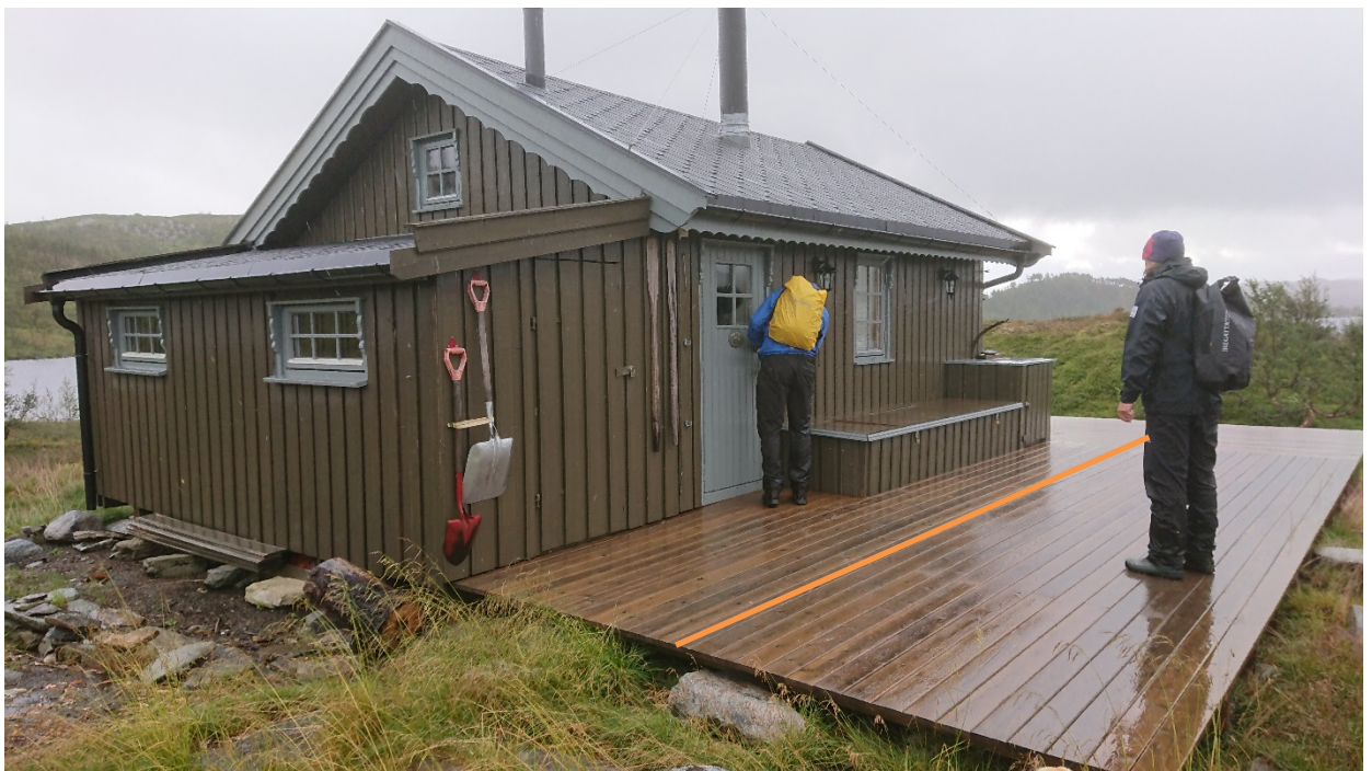
Bilde 3 Plattingen utenfor hyttas inngangsparti. Denne kan krympes betraktelig inn (oransje linje på ca. 2 meter fra ytterkant) uten at den mister sin funksjon. Det er denne delen av plattingen som er mest synlig i terrenget. Til venstre for hytta er tilbygget som fungerer som uthus/utebod. Tilbygget har inngang både fra innsiden og fra kortsiden.
