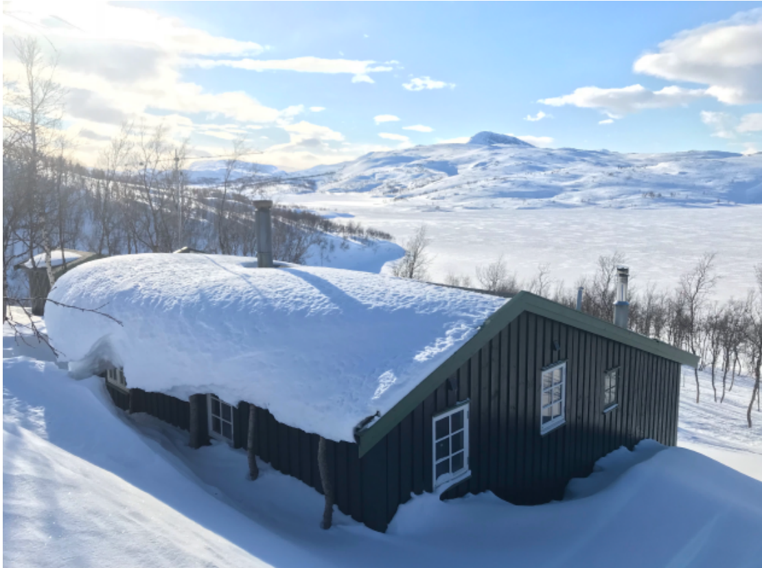
Figur 1: Bilde er tatt tidlig vinter før hytta er snødd igjen. Det blir lagt stort press på taket fra vekten av snøen.
