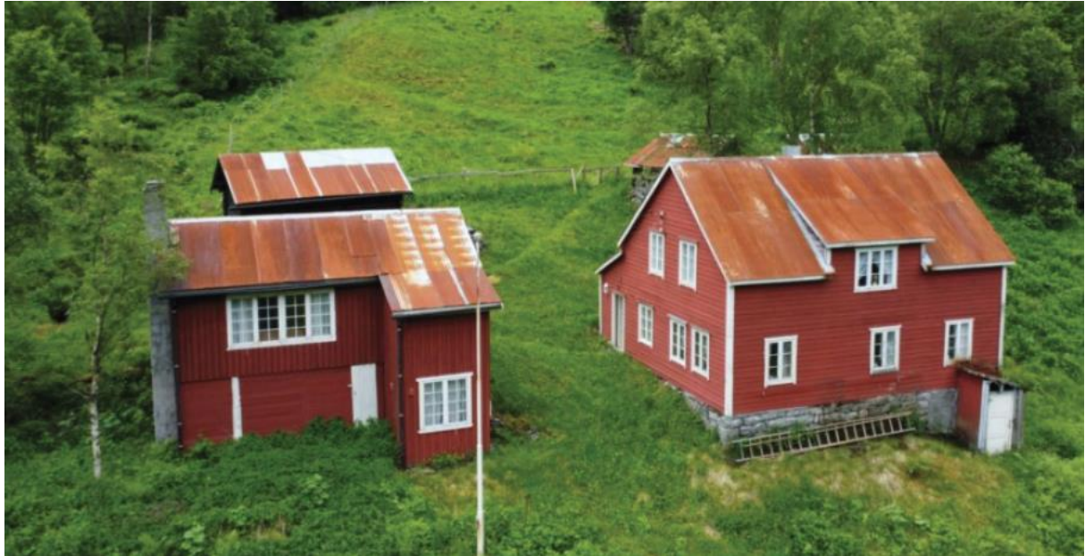
Bilde 1 Grunneier ønsker å ruste opp det minste bolighuset som er til venstre i bildet ovenfor. Fasade Nord.
