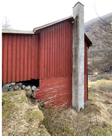
Bilde 3 Fasade sett fra øst.
