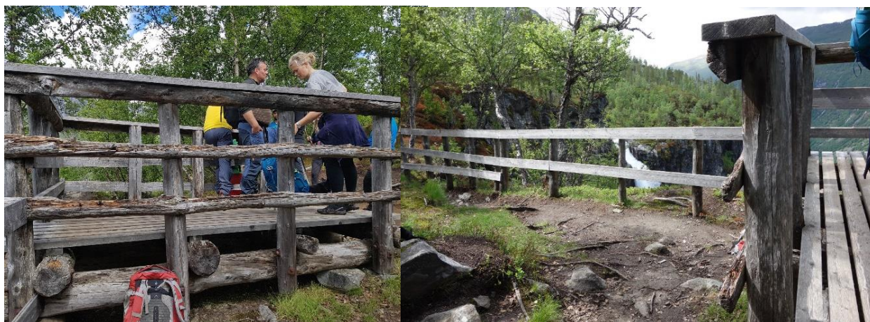
Figur 1: Bilde viser noe av slitasjen på eksisterende plattform Figur 2: Slitasje på eksisterende plattform og gjerde
