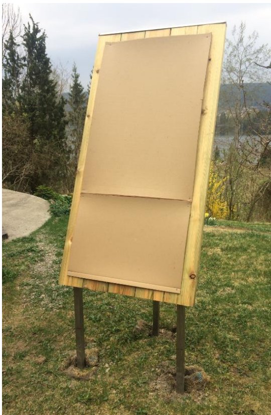
«Prototype» frittstående plakatstativ. Plakatunderlag foreløpig i impregnert og plakat i papp. Plakatunderlag 163 x 63. Understell skal senkes 15 cm lavere enn på bildet. Til temaplakater: Ca. halv størrelse.
