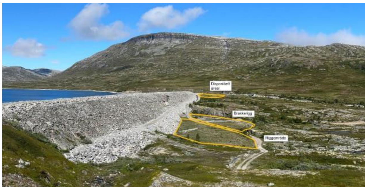
Figur 4-6. Oversiktsbilde over plassering av riggområder.
