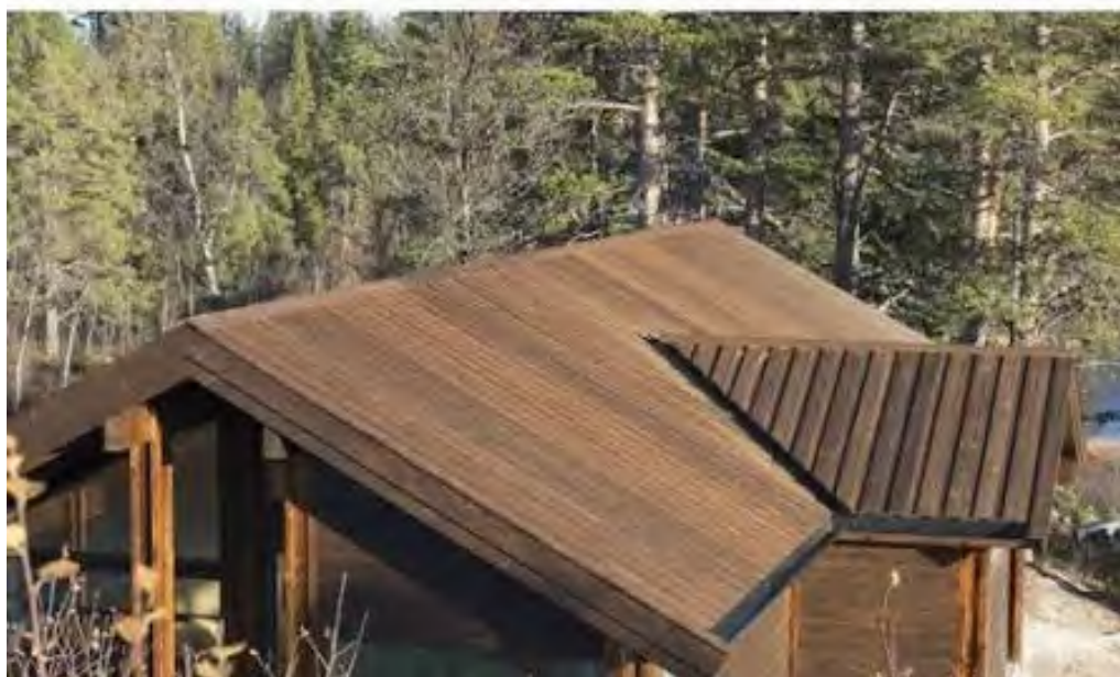
Fig. 4: Omsøkt materiale på tak på både uthus og seterhus, dvs. tretak /bordtak
