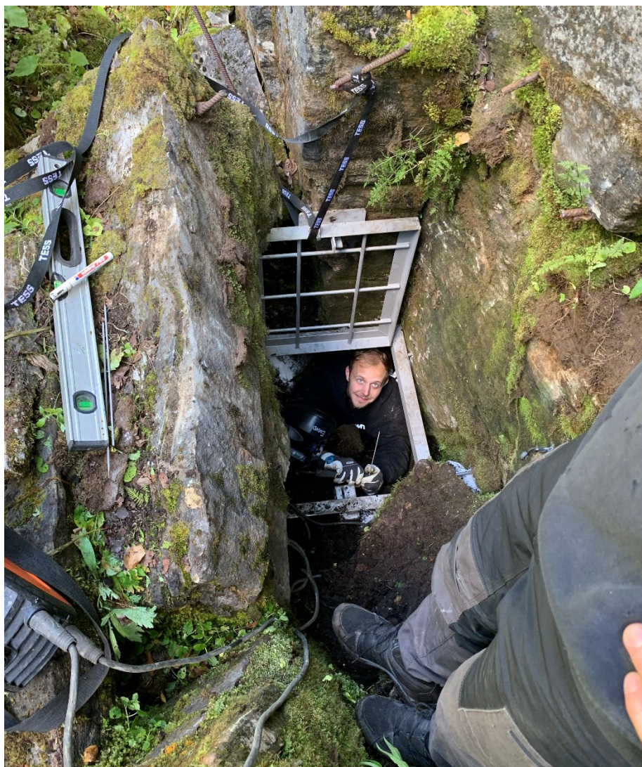
Figur 22. Montering av nye grotteporter i Rana («prosjekt grotteporter» ved Statsforvalteren i Nordland). Ny port i sandblåst, rustfritt stål. Materialet er solid og med matt farge som med videre anløpning passer fint mot natur og grå kalkstein. Låskasse for hengelås ved personens hånd, fjellveggen bak skal forsynes med en hekte som kan holde porten åpen under bruk.
