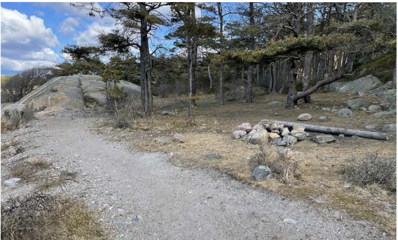
På midtpartiet mellom rampene skal stien beholdes og forsterkes med et hardpakket lag med subbus.
