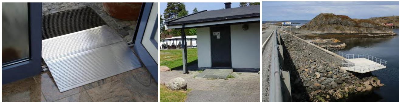
Figur 5: Terskelbro til venstre, skråningen (kartlegges som rampe) i midten og rampe på høyre.
