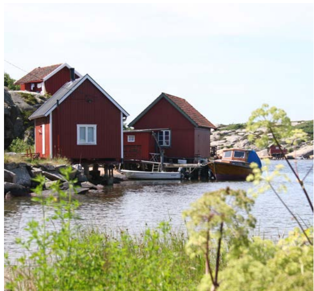
Sjøbuene i Kuvauen er fredet etter kulturminneloven.
