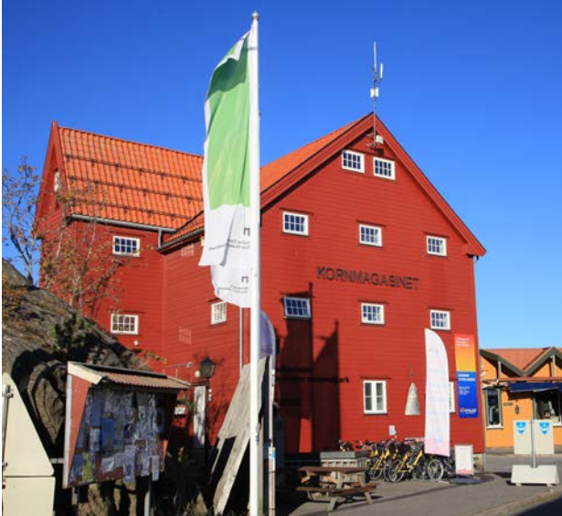
Besøksenteret i det gamle kornmagasinet på Skjærhalden.
