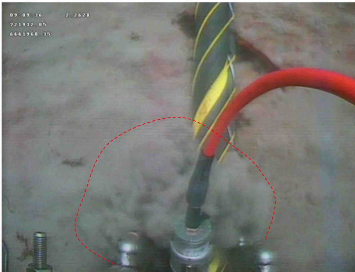
Figur 2. Oppvirvling av sediment under installasjon av sjøkabel med Nexans sin CapJet spylemaskin. Patikkelsky er innenfor den stiplede røde linjen.
