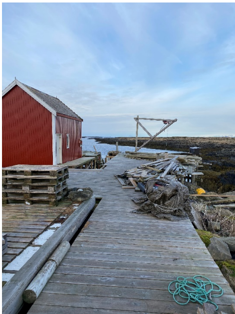
Bilde 3 Den aktuelle kai, sett fra sørenden. Utvidelse mot øst kan ses til høyre i bildet. Tatt av forvalter under befaring
