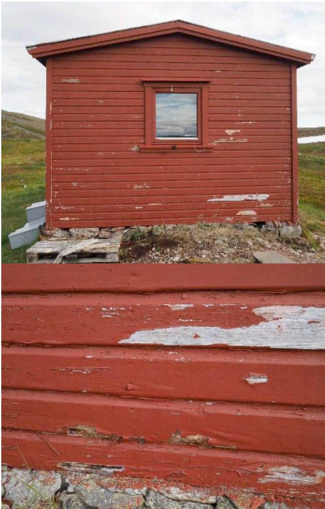
Bilde 1. og 2. Viser noe av forfallet på hytta, med avflasket maling og råte i bordkledning. Foto. Rolf Ims.
