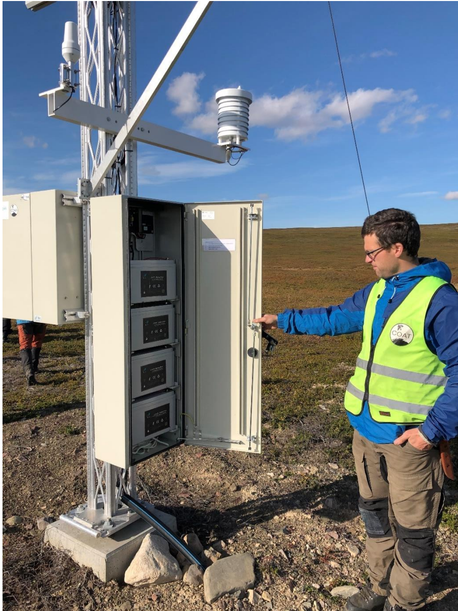
Skap med teknisk utstyr og fundament.
