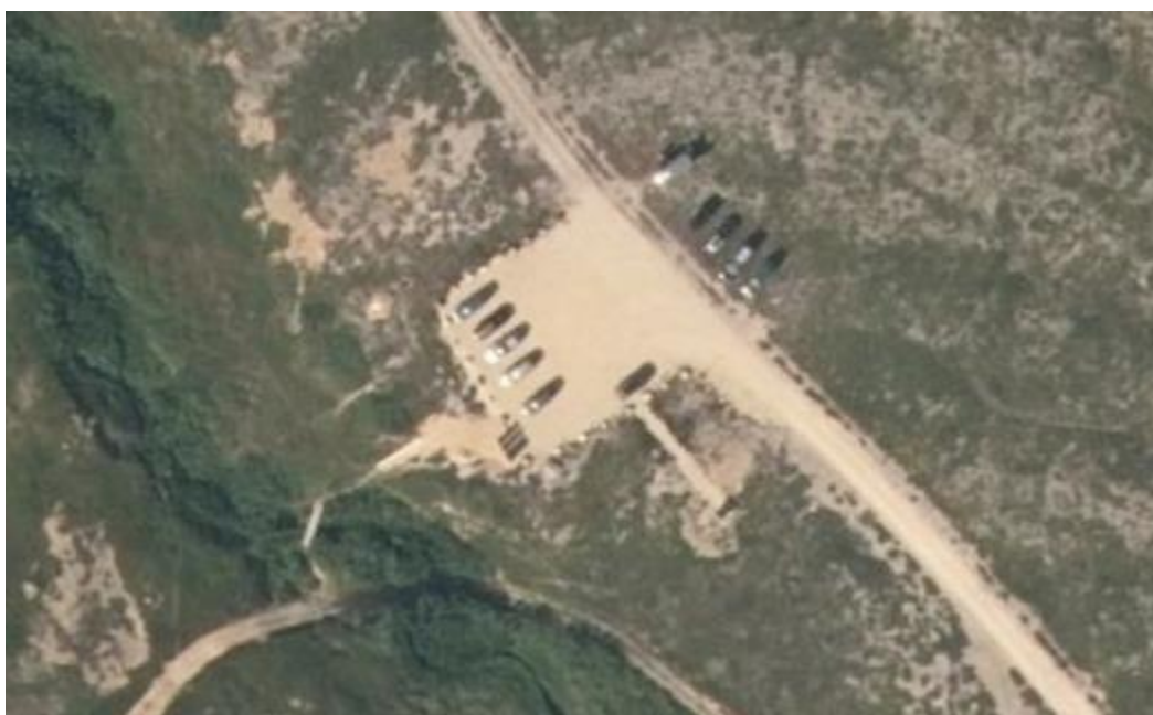
Parkering – startpunkt Komagdalen med plan for utvidelse av P- areal (der biler står parkert i marka). Tiltaket er påbegynt men ikke ferdigstilt.
