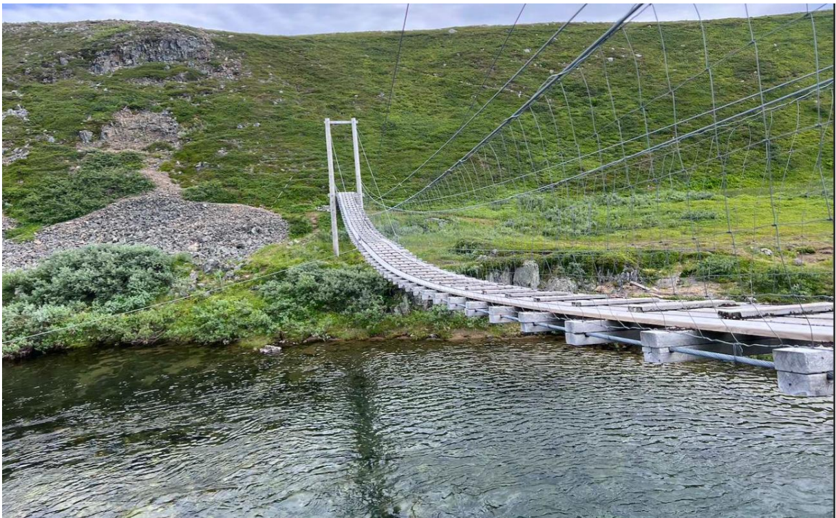
Hengebrua Komagdalen befart
