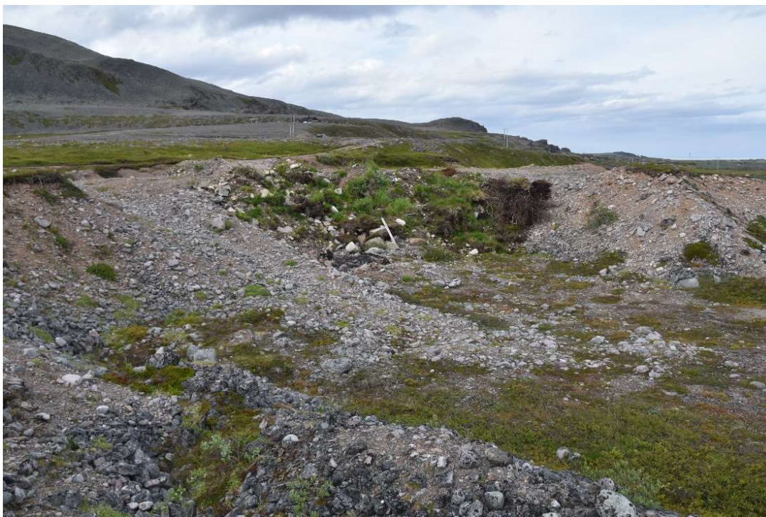
Figur 14. Skråningen mellom de to nivåene terrengformes forsiktig, adkomstvegen fjernes og tippmassene spres ujevnt i øvre del av skråningen (med mindre de inneholder fremmede arter).
