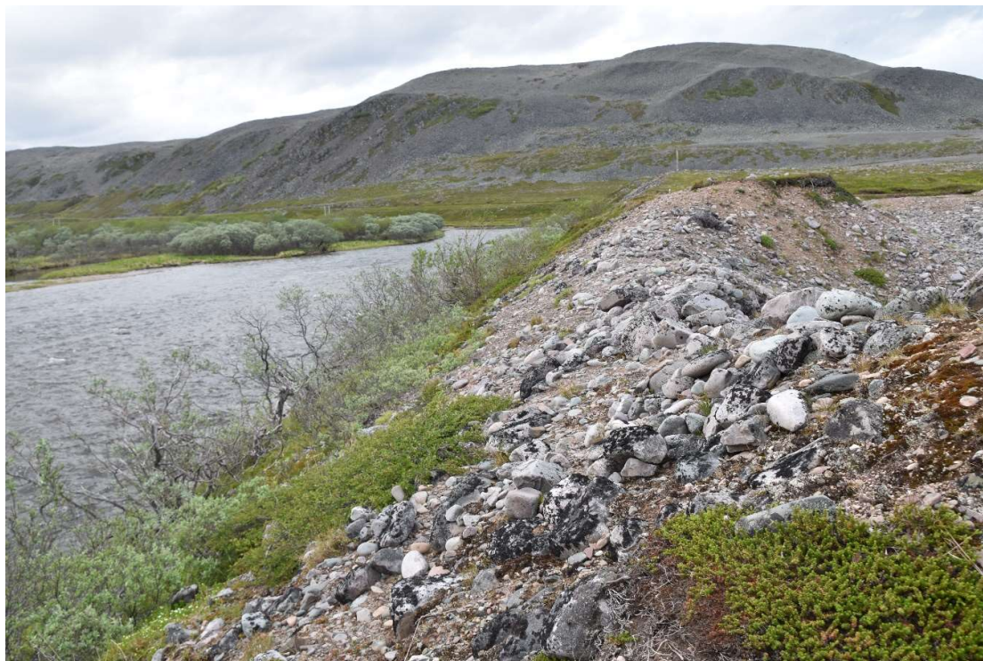
Figur 16. Til tross for at grustaket ligger like ved elva er elvebredden uforstyrret. Det er helt vesentlig for et vellykket tiltak at det ikke påvirker elvebredden eller fører til at masser havner i elva.
