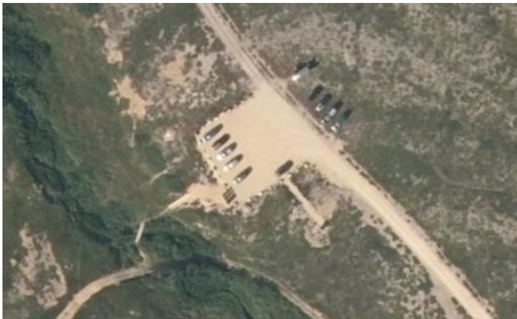
Parkering – startpunkt Komagdalen med plan for utvidelse av P- areal (der biler står parkert i marka). Tiltaket er nå gjennomført – gruset og stolper rundt parkering satt opp.
