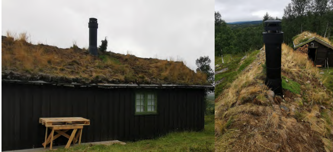
Ny pipe på fritidsbolig gnr/bnr. 151/19 i Jøldalen etter arbeidet sommeren 2025.
