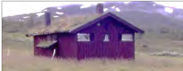
Fasade nord og øst
