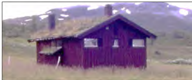
Fasade nord og øst
