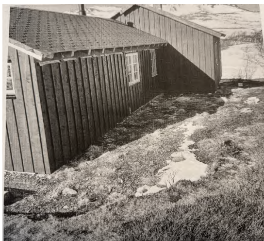
Figur 2. Bilde av nordsiden av hytten. Viser ønsket plassering for plattingen. Sendt av Steinar Løseth 13.05.2025.
