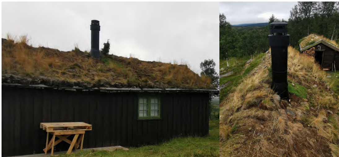
Ny pipe på fritidsbolig gnr/bnr. 151/19 i Jøldalen etter arbeidet sommeren 2025.
