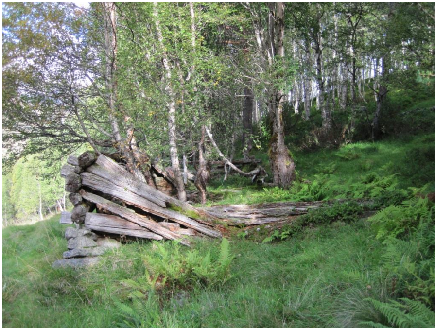
Forfalt seterfjøs på Kontrabakken, Vindøldalen i Surnadal – Foto Hege Sæther Moen.
