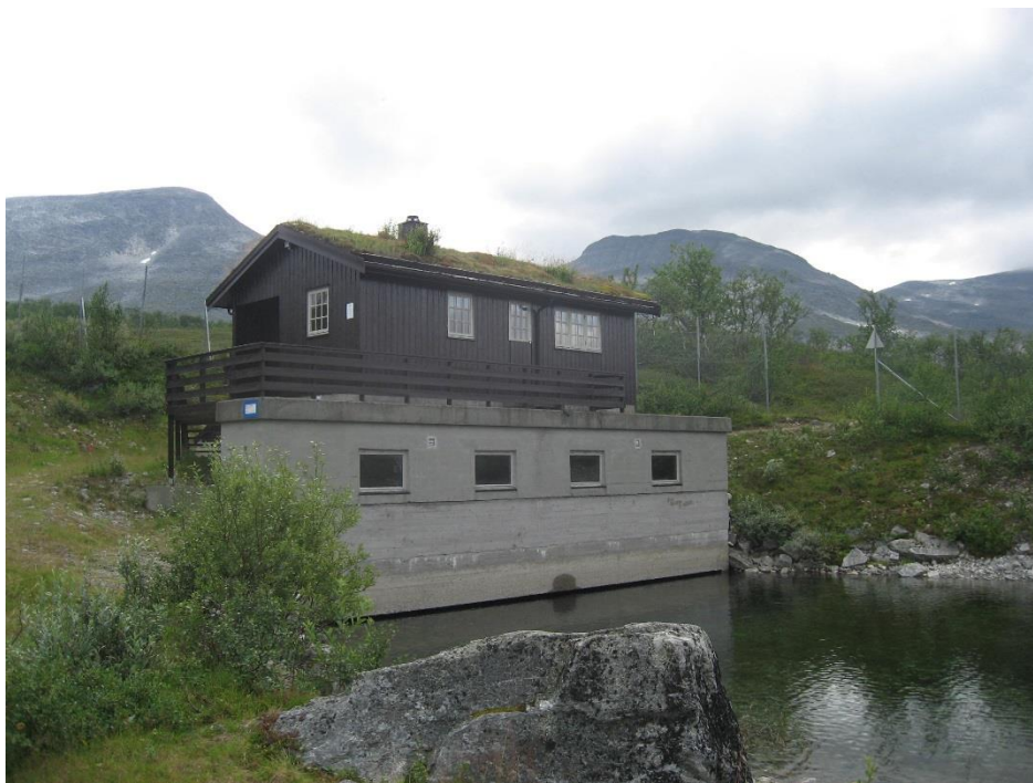
Vatnet fra Tovatna blir ført inn i driftstunnelen til Driva Kraft via Østre Tovatnet. Foto: Trygve Hesthagen.
