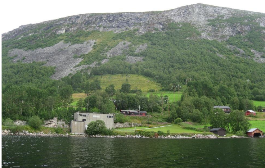
Pumpestasjonen ved Vasli, Ångardsvatnet. Foto: Trygve Hesthagen.
