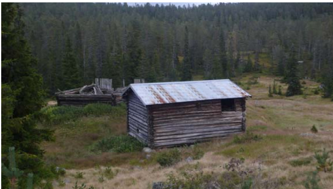
Fjøs tilhørende gbnr.42/3. Vi ser luka til høytrevet i vestveggen. Bak er sammenrast fjøs.
