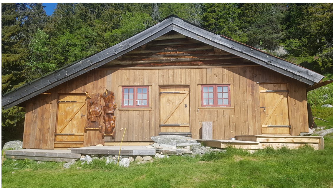
Bilde 2: Hva er trapp og hva er platting? Problemstilling som forvaltningsstyret ønsker å belyse. Minneskleiv seter.
