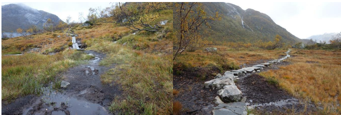
Figur 3.5. I den første strekningen fra Stølsvatnet til Steinslandsstølen er stien forsterket i flere av de fuktigste delene.
