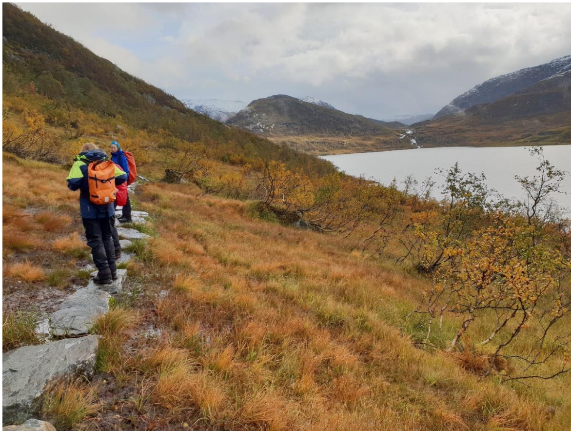
Figur 3.2. Steinlegging som «sherpasti» langs Stølsvatnet og helt inn til turisthytta ved Solrenningen.
