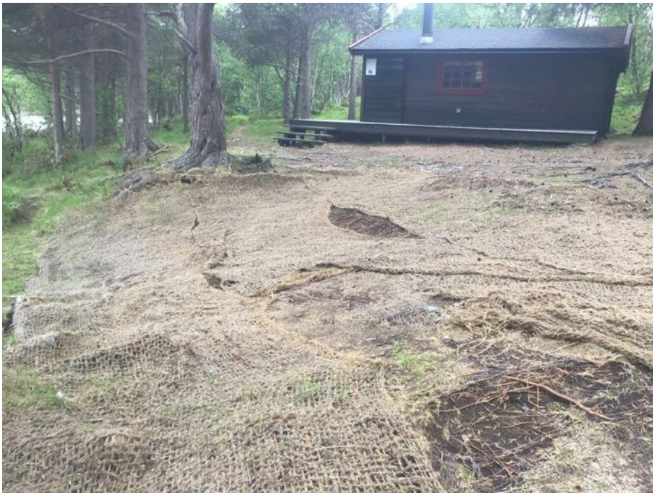
Figur 10. Utlagte kokosmatter i elveskråningen ned mot elva.
