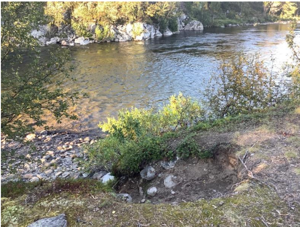
Figur 6. Slitasje på grunn av mye ferdsel ned elvebrinken som blir etterpå blir utsatt for erosjon fra elva.
