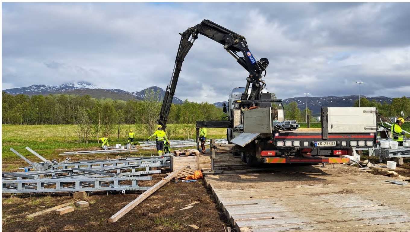
Figur 2: Foto fra en anleggsplass der det er benyttet stokkmatter til oppstilling av tungtransport. Stokkmattene kan også legges som "klopper".
