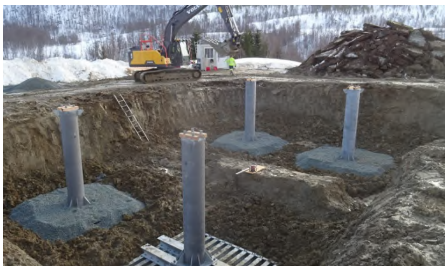
Figur 1 Eksempel på et typisk prefabrikkert mastefundament. Prinsippet er at man tar vare på det øverste topplaget av vekstmasser, som legges tilbake på toppen i forbindelse med tilbakeføring og istandsetting av naturen. Fundamentene som skal benyttes i Stabbursdalen landskapsvernområdet kan skille seg fra fundamentene som er vist på dette bildet.
