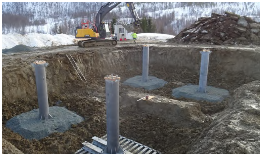
Figur 2 Eksempel på et typisk prefabrikert mastefundament. Prinsippet er at man tar vare på det øverste topplaget av vekstmasser, som legges tilbake på toppen i forbindelse med tilbakeføring og istandsetting av naturen. Fundamentene som skal benyttes i Stabbursdalen landskapsvernområdet kan skille seg fra fundamentene som er vist på dette bildet.
