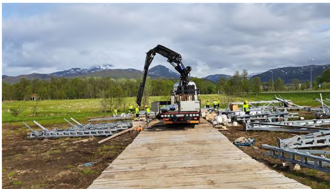
Figur 17: Anleggs plass med lossing og premontering av mastestål hvor det er benyttet stokkmatter som terrengforsterkning for transport.
