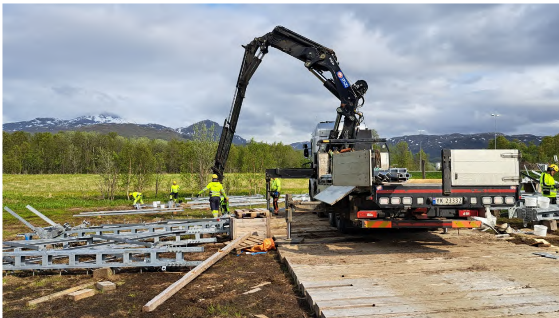
Figur 3 Eksempel på bruk av stokkmatter til terrengforsterkning på en oppstillingsplass.
