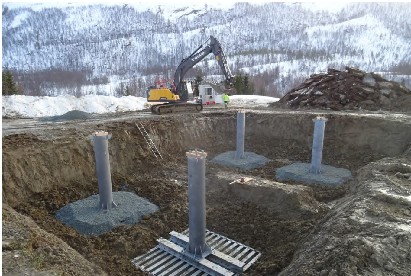
Figur 1: Bilde av et mastepunkt for 420 kV ledning som klargjøres med prefabrikerte mastefundamenter. Det er vil være behov for mellomlagring av løsmasser ved siden av hvert mastepunkt.
