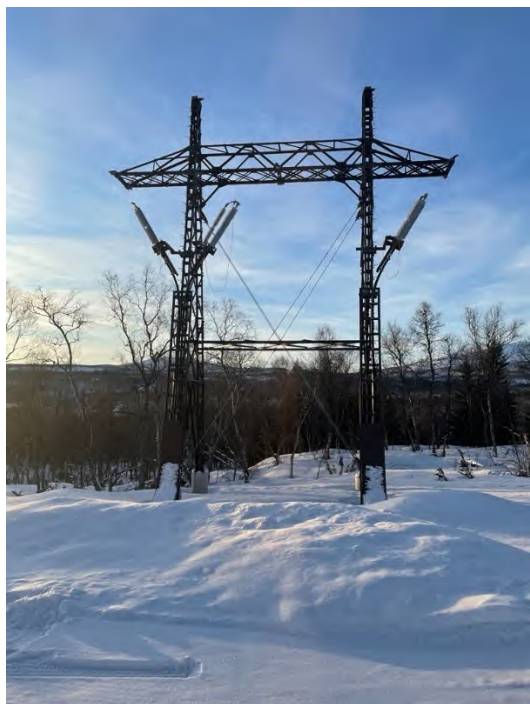
Figur 11: Eksempel på kabelendemast for 132 kV kabel.
