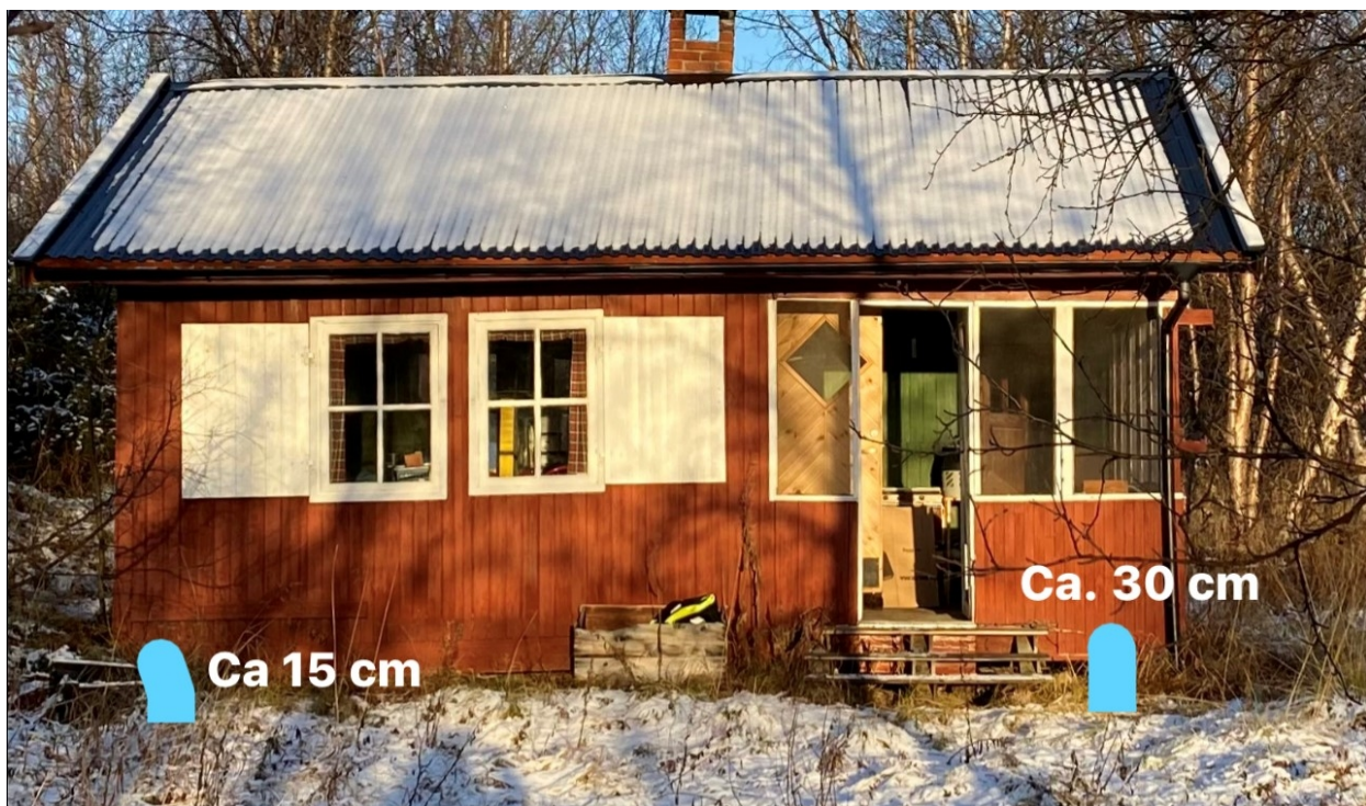
Bilde av hytten tilsendt i søknaden. Stolpehøyden er per i dag 15 cm i bakkant og 30 cm i framkant (sett fra elven).
