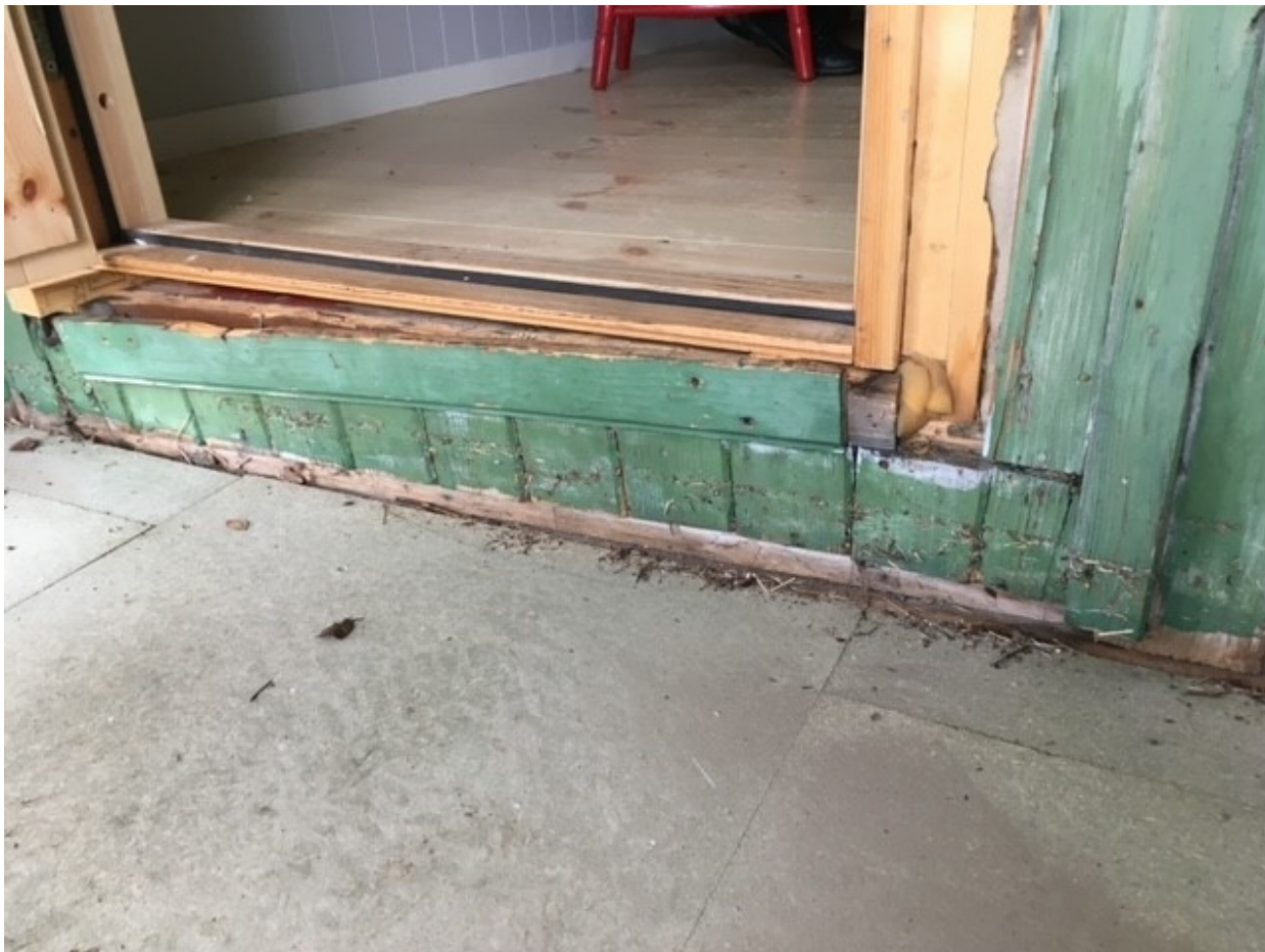
Bilde av vannskade innvendig i hytta tilsendt i søknaden.
