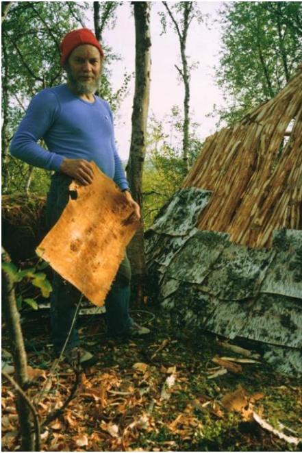
Never er flott materiale, så gammen ikke blir fir tett.
