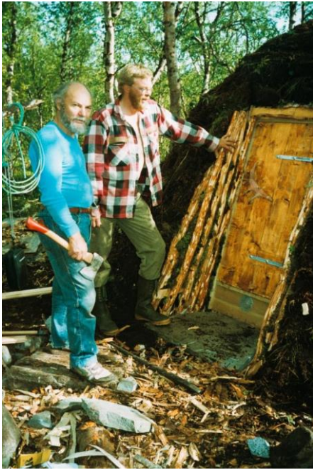
Montering av medbragt dørkarm og dør.
