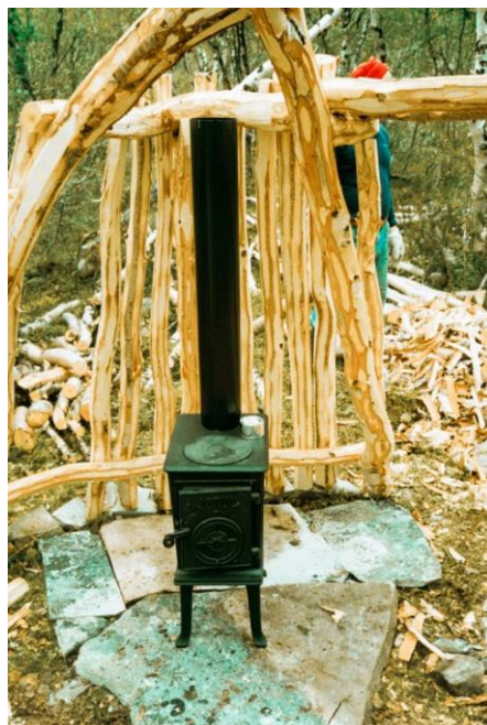
Ferdig rammeverk. Stokkene mot bakken settes på en flat stein. Gode steinheller til ovnen. Legg merke til buestokken til pipa.
