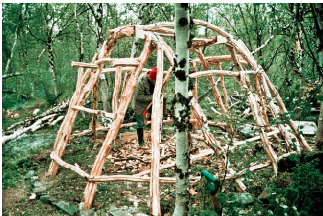
Ferdig rammeverk. Stokkene mot bakken settes på en flat stein. Gode steinheller til ovnen. Legg merke til buestokken til pipa.
