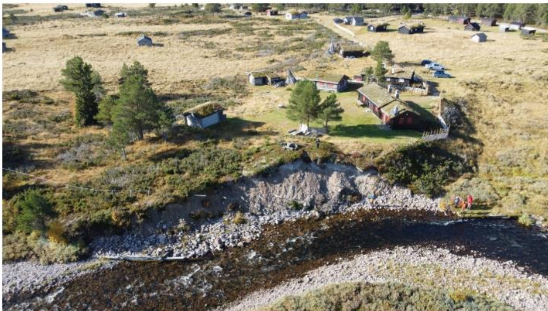
Figur 3-1 Dronefoto av bruddskaden i elvemel. Bildet er tatt fra øst mot vest.
