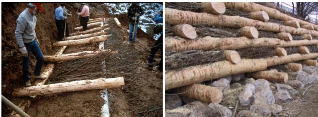
Figur 4-7 Kistevegg kan gjerne kombineres med beplantning av stiklinger, slik som på figurene. Vestre: Under installasjon. Høyre: Nyinstallert. (Bilder hentet: hvv. venstre og høyre )
