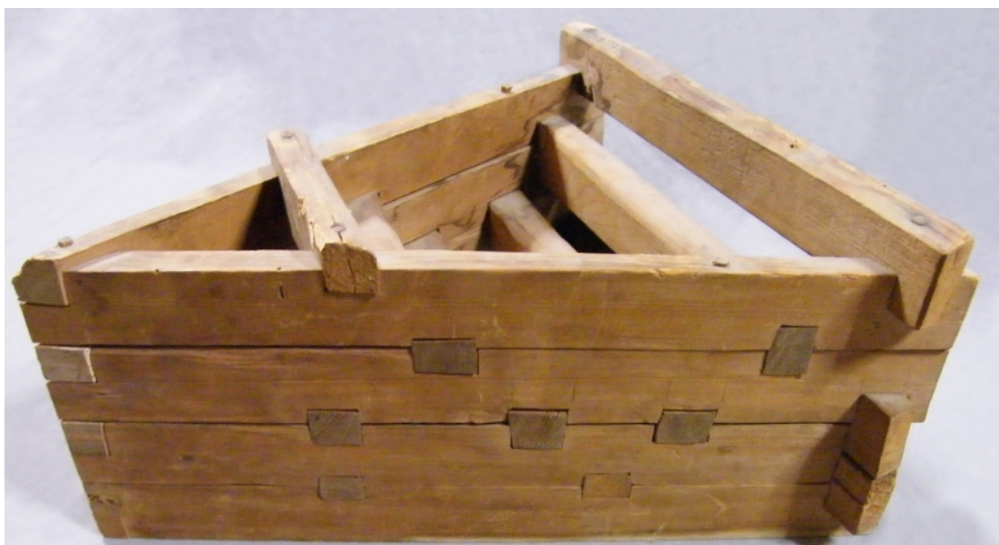
Figur 4-3 Modell av et element i en tømmerkisteforbygning (hentet fra: digitaltmuseum.no ).
