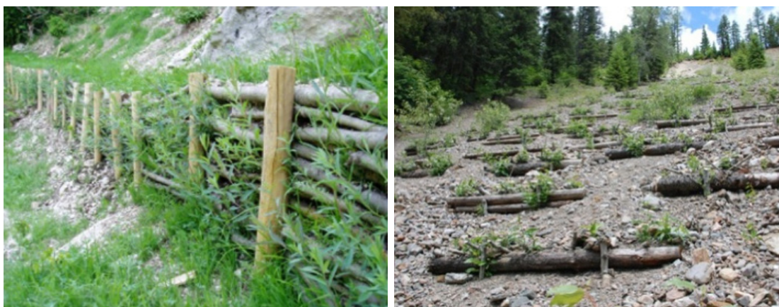
Figur 4-8 Venstre: Delvis terrassering vha. palisadevegg. Høyre: "modifisert lagermetode". (Bilder hentet fra (Rey et al., 2019))
