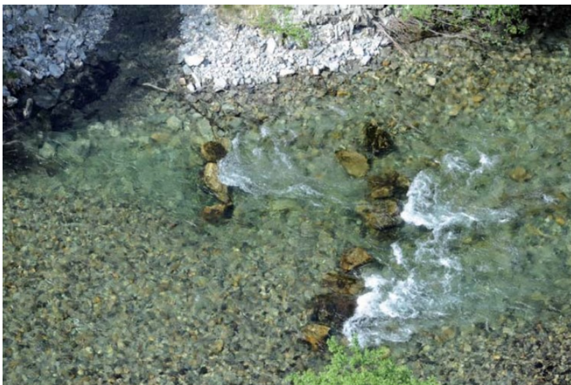
Figur 4-1 Buner laget av stein som styrer strømningsretningen til elva over mot motsatt bredd. Elva renner her fra venstre mot høyre (Fergus et al., 2010).
