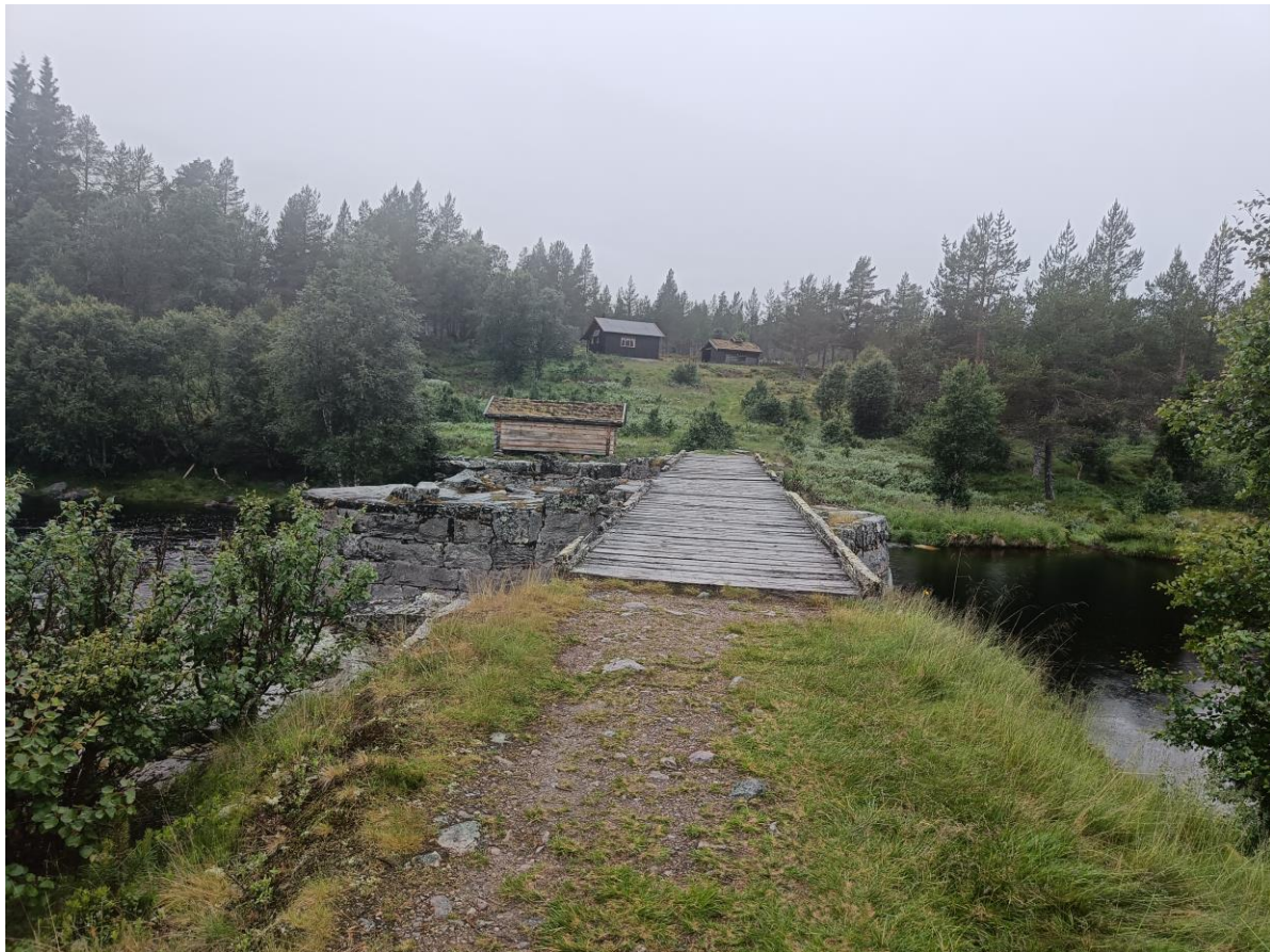
Figur 7.6.33. Kulturmiljøet ved Nydammen (Misterdammen) i Mistravassdraget vitner om den omfattende tømmerfløtingen som foregikk i Rendalen. Foto: B. Bele/NIBIO.
