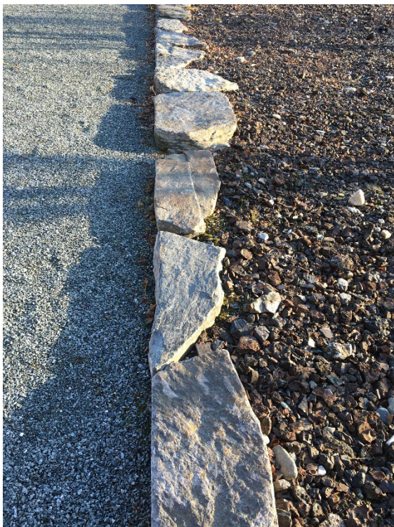
Figur 9 og 10: Bilde som viser natursteinskant (til venstre) og bilde fra innfallsport i Elgå som viser skiferkant.
