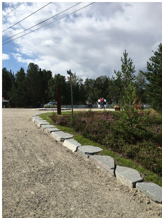
Figur 9 og 10: Bilde som viser natursteinskant (til venstre) og bilde fra innfallsport i Elgå som viser skiferkant.
