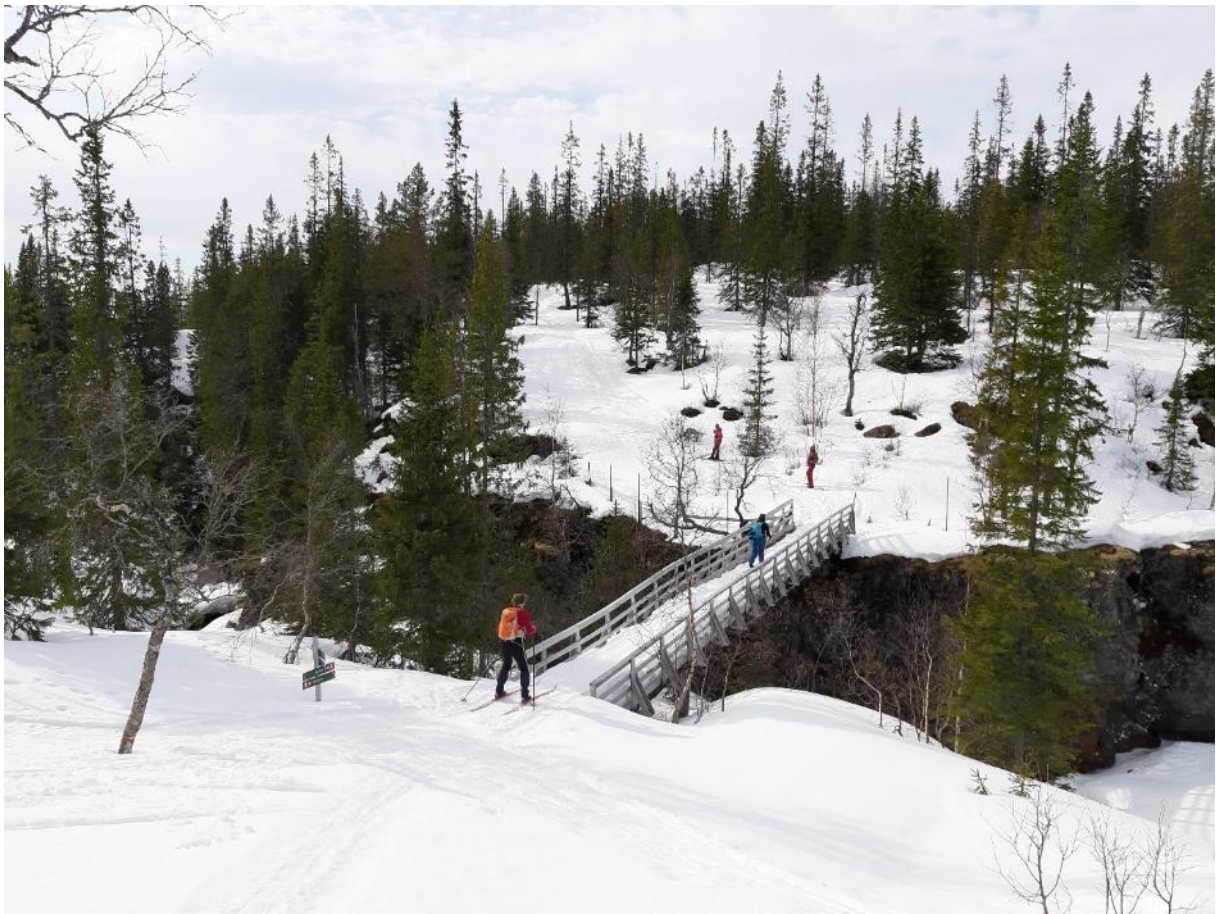
Brua over Rotla ved Svenskmoen april 2021. Foto: Eskil Følstad.
